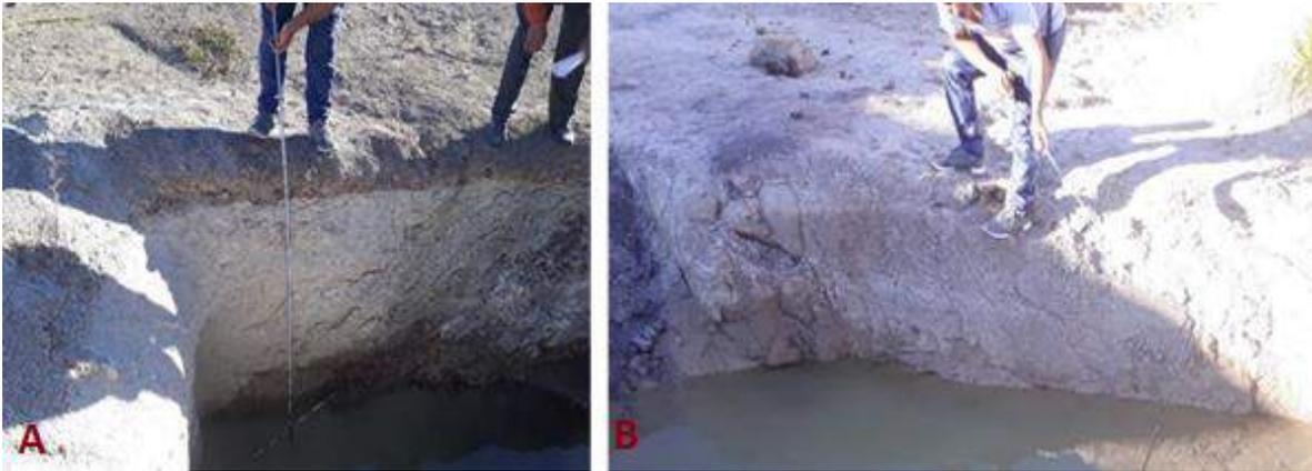
Fotografía 3. 3: (A) Calicata N° 07 y (B) calicata N° 08 afloramiento del nivel freático a 1.0m y 0.4m respectivamente, ubicadas en el centro del área de cimentación.
