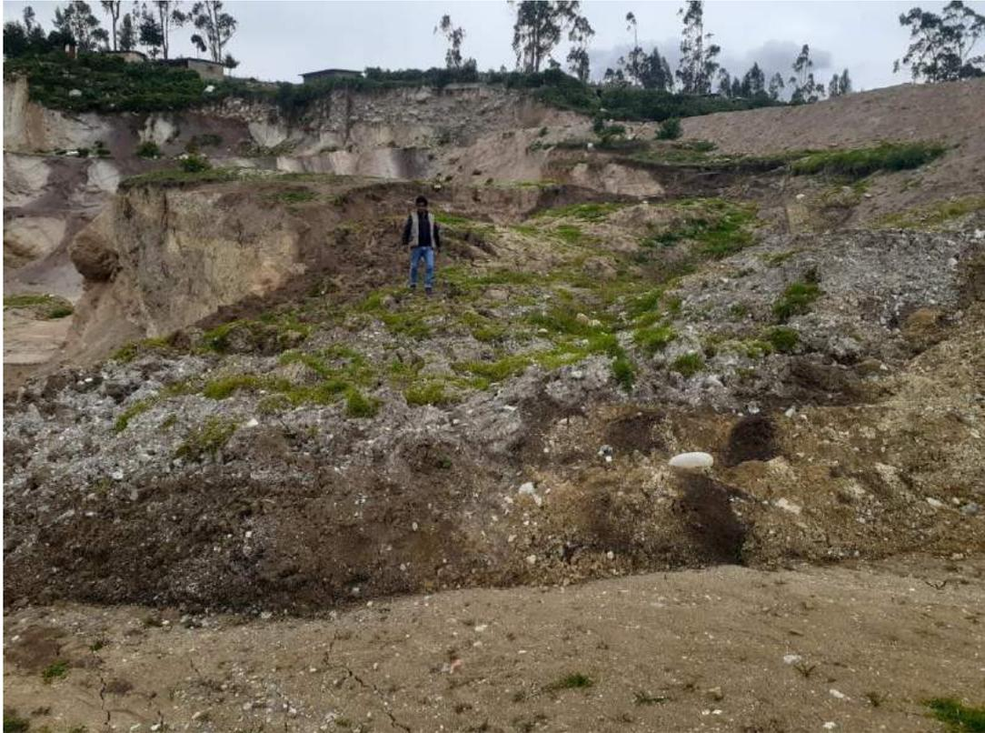
Fotografía 6. 3: Remoción de masas de taludes generados por el corte hecho para la cimentación.
