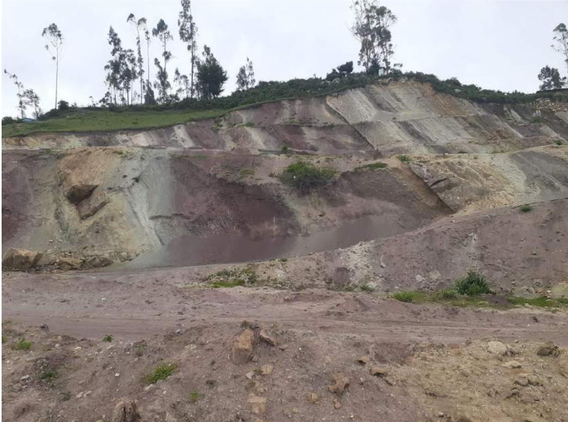
Fotografía 6. 7: Corte del área de cimentación donde aflora los estratos de la Formación Chota.
