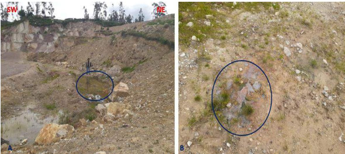
Imagen 3. 15: (A) Calicata N° 11 presencia de nivel freático a 0.2m del nivel del suelo. (B) Calicata N° 09 indicio del nivel freático.
