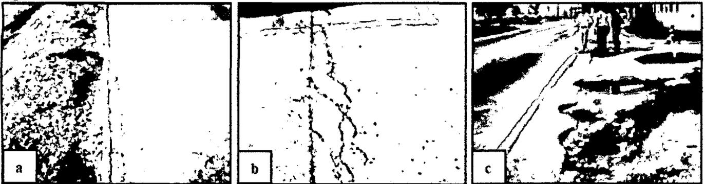
Figura 2.10 Fisura de borde de nivel de severidad bajo (a), medio (b) y alto (c). (Fuente: Rodríguez, 2009)
