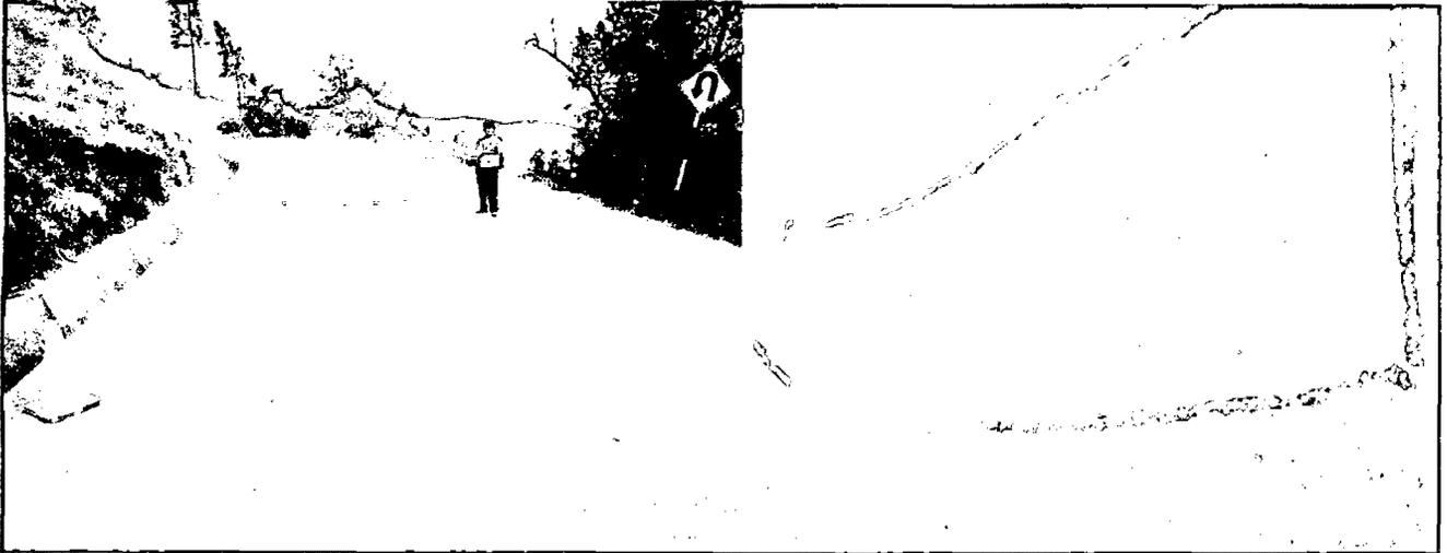
Figura 5.54 Unidad de Muestra - 35. Peladura de severidad baja.
