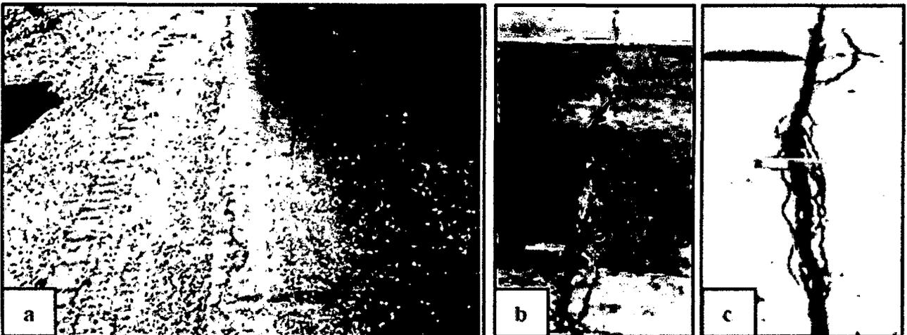
Figura 2.11 Fisura de reflexión de junta de nivel de severidad bajo (a), medio (b) y alto (c). (Fuente: Rodríguez, 2009)
