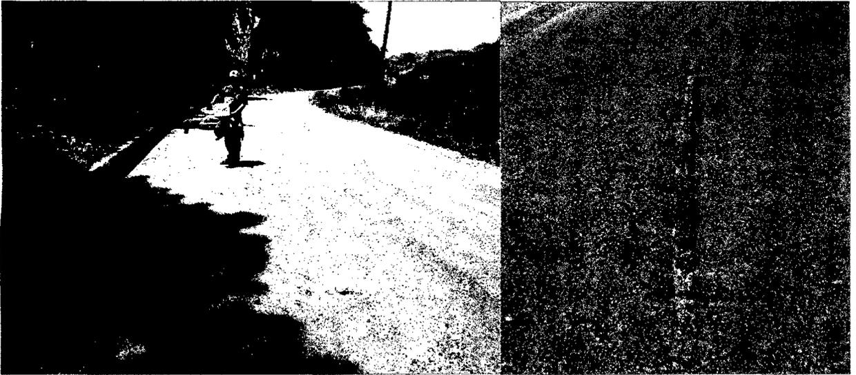
Figura 5.26 Unidad de Muestra - 07. Fisura Longitudinal de severidad Media.
