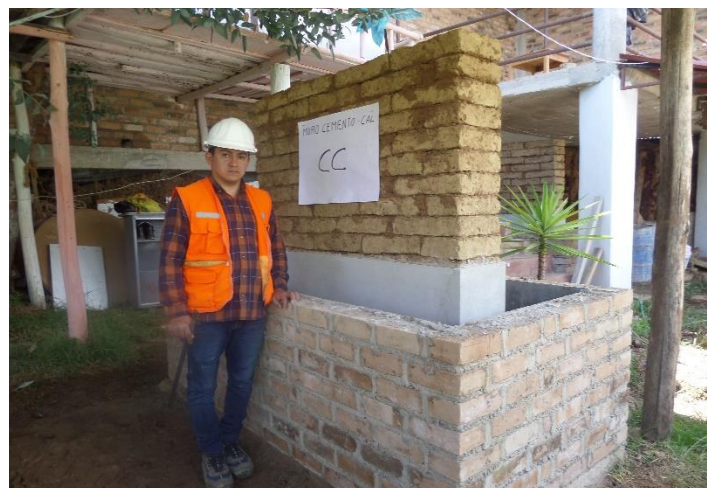
Figura 132: Muro Cemento - Cal
