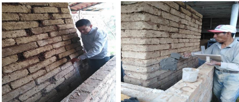
Figura 130: Aplicación del Recubrimiento - Tarrajeo mortero Cemento - Cal
