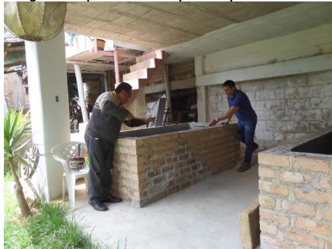
Figura 4: Supervisión de los pozos impermeabilizados
