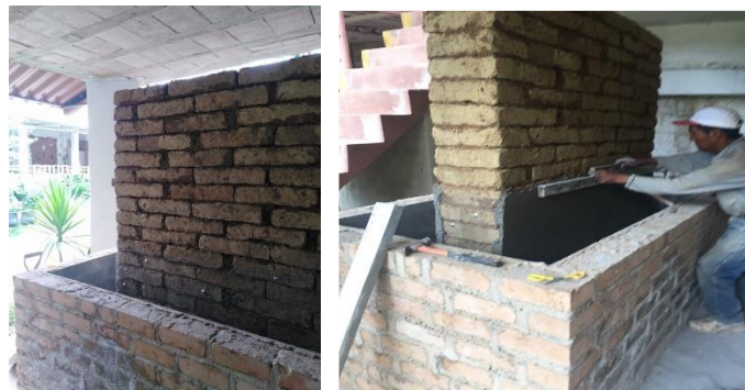
Figura 138: Aplicación de Recubrimiento - Tarrajeo mortero Cemento – Yeso
