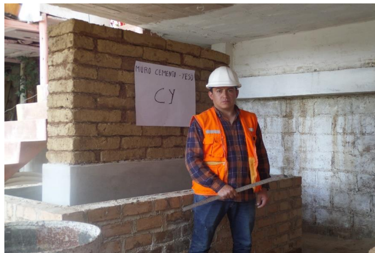
Figura 140: Muro Cemento - Yeso
