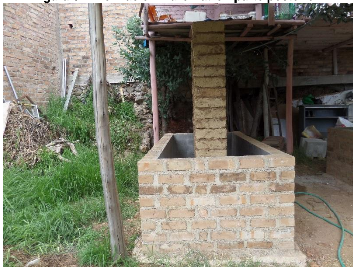
Figura 64: Inclinación Muro Patrón parte posterior
