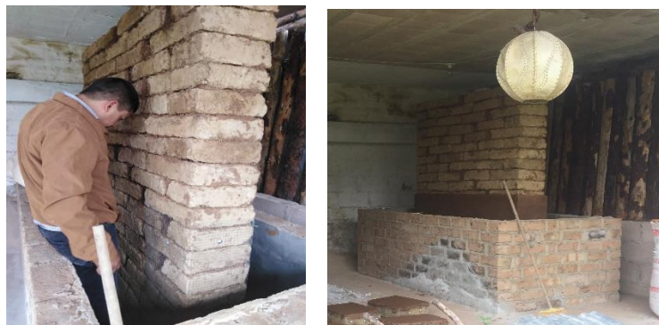
Figura 134: Aplicación de Recubrimiento - Tarrajeo mortero Tierra Roja – Cal
