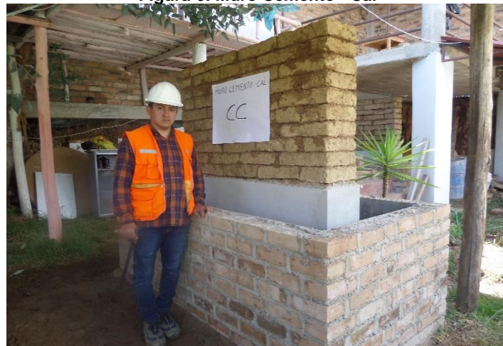
Figura 6: Muro Cemento - Cal
