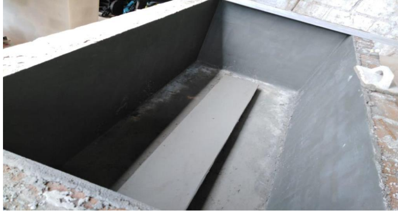
Figura 125: Sobrecimiento de 50 mm
