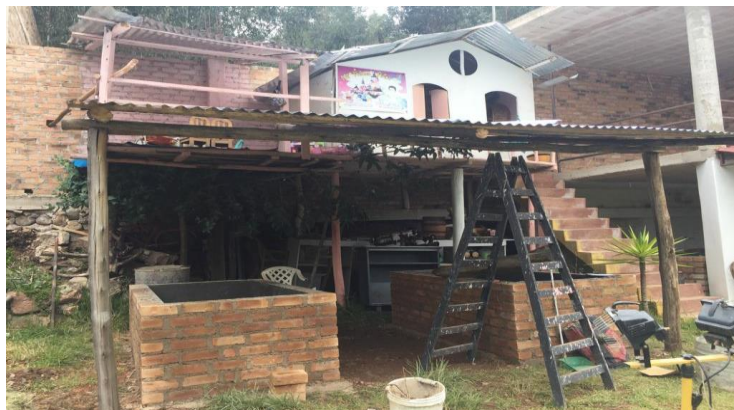
Figura 126: Pozos Impermeabilizados MP - CC
