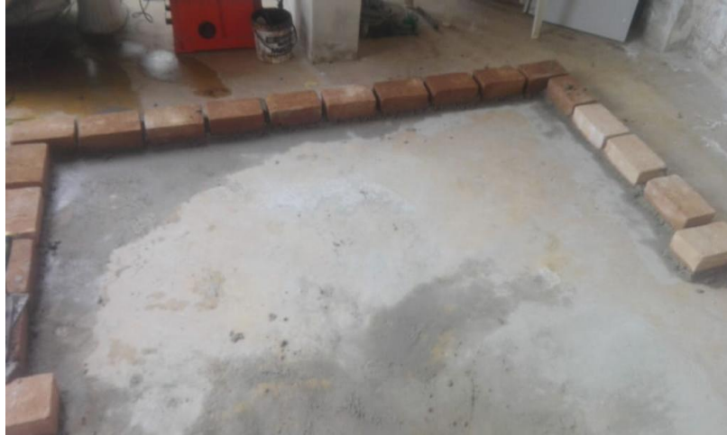
Figura 123: Inicio construcción pozos
