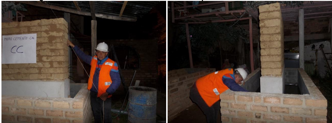
Figura 84: Verificación estado de los muros tercer periodo - Muro Cemento – Cal
