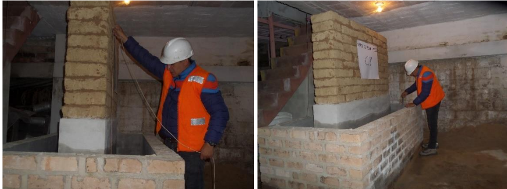
Figura 83: Verificación estado de los muros tercer periodo - Muro Cemento - Yeso
