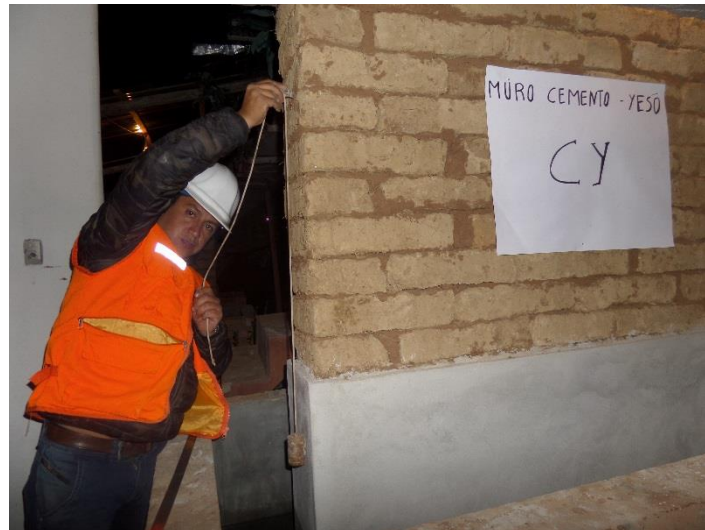
Figura 70: Verificación de la Verticalidad del muro Cemento – Yeso
