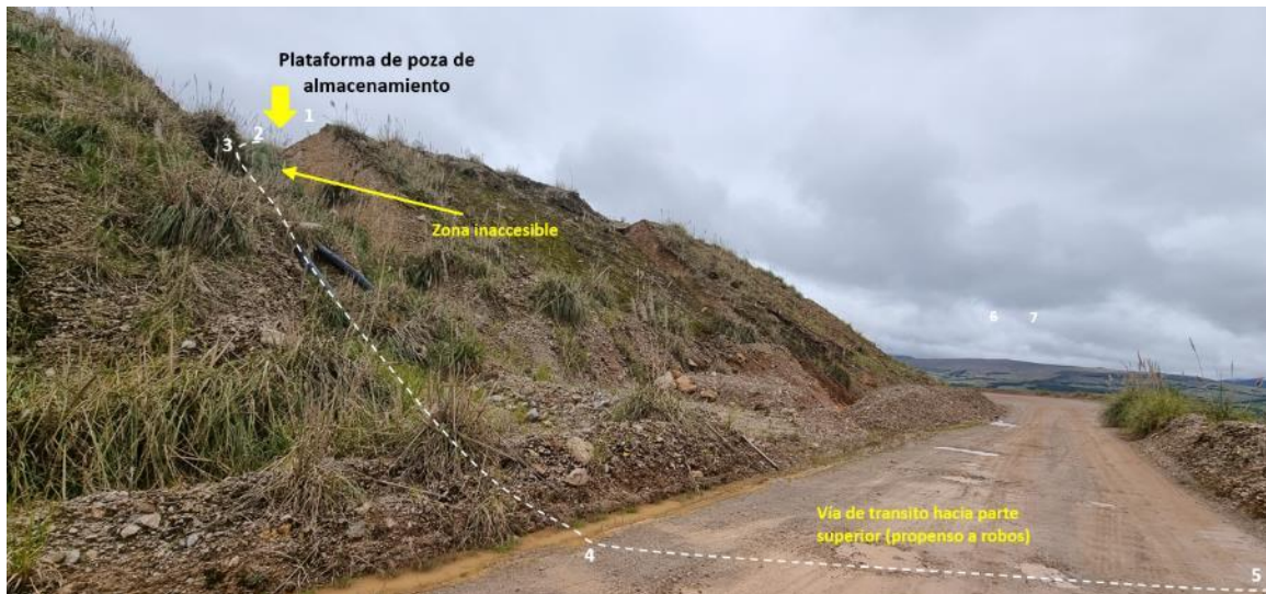
Figura 61: Fotografía de zona inaccesible para ubicación de inyector
