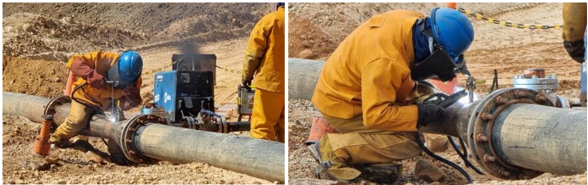
Figura 81: Soldadura en campo para implementación de más puntos de medición
