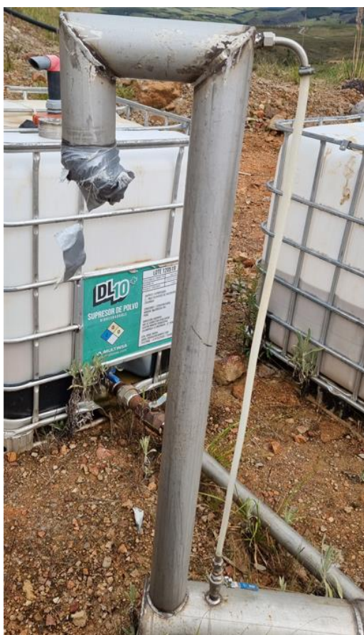
Figura 87: Aireador 4 pulgadas y visor de nivel con el uso de manguera transparente.
