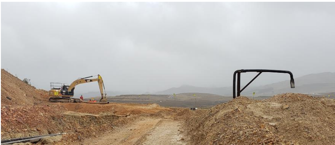
Figura 79: Trabajos preliminares para instalación de Venturi
