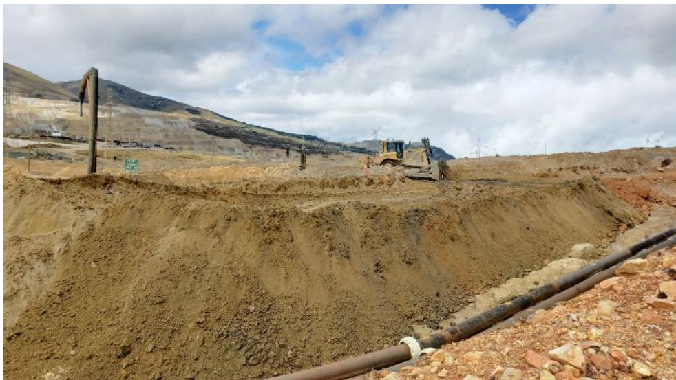
Figura 67: Canal de drenaje y cruce de tuberías en plataforma media de garza.
