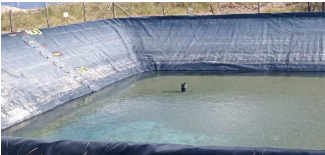
Figura 55: Poza de almacenamiento de agua con salida en parte baja de poza.
