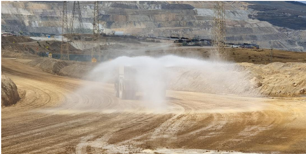
Figura 102: Riego de vía de acarreo con cisterna gigante
