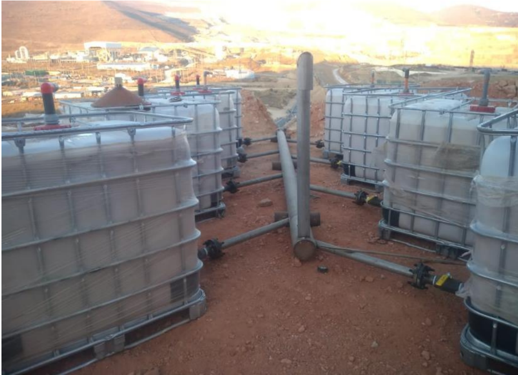
Figura 86: Instalación de contenedores a manifold
