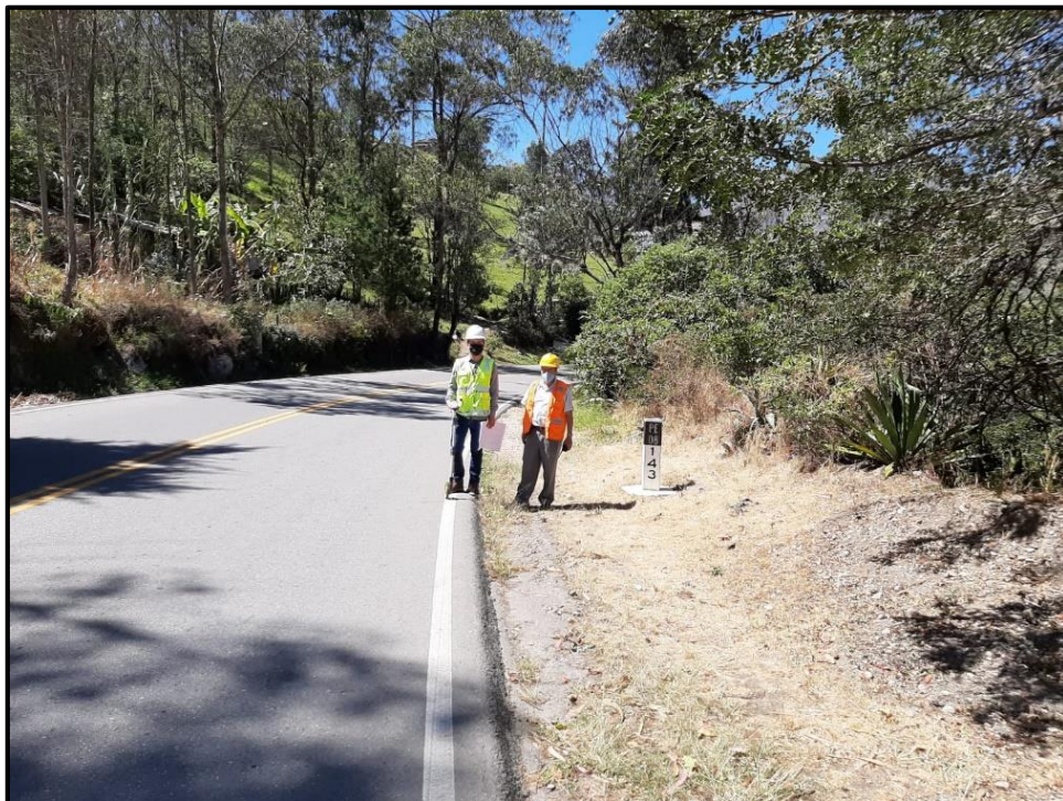
Imagen 10. Inspección del asesor en los trabajos de campo
