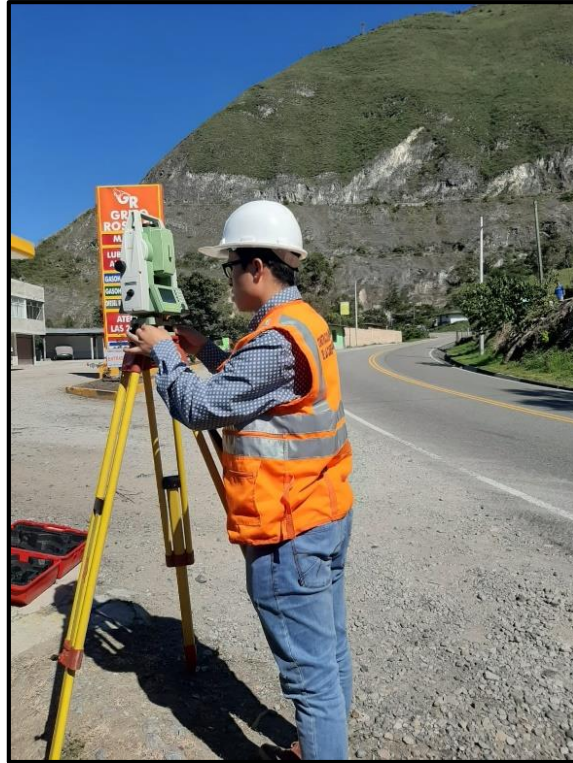
Imagen 4. Nivelación de la Estación Total
