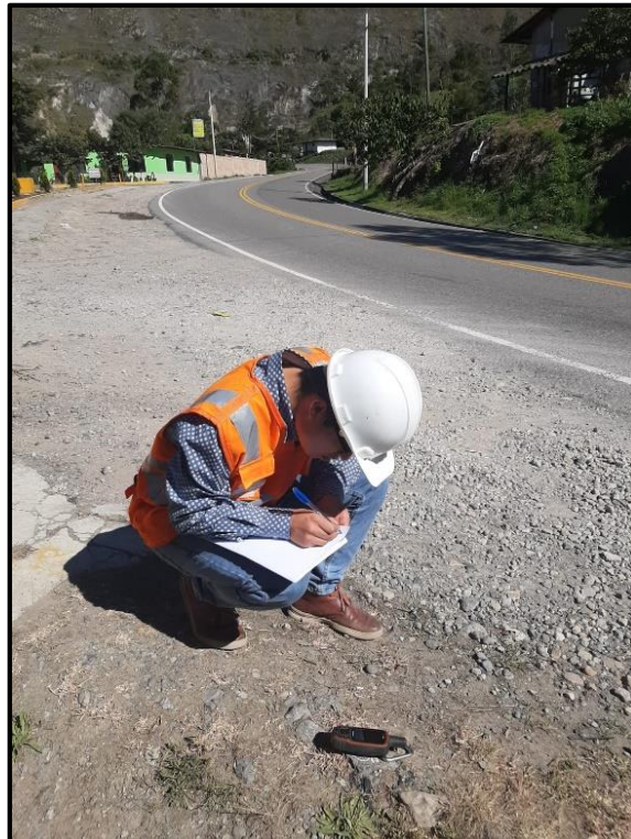
Imagen 5. Toma de coordenadas para iniciar el levantamiento topográfico
