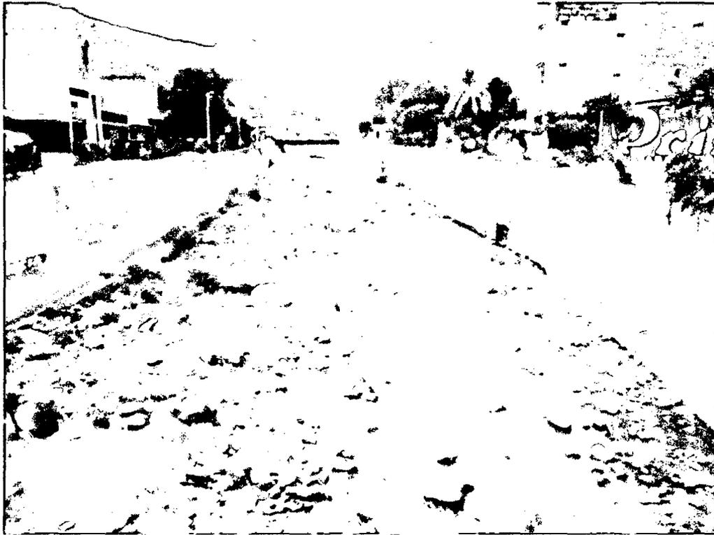
Imagen 05. Vista del tramo puente Pardo y Miguel – puente Mesones Muro, en cambio en esta imagen se observa la socavación que se ha generado en los muros de contención.
