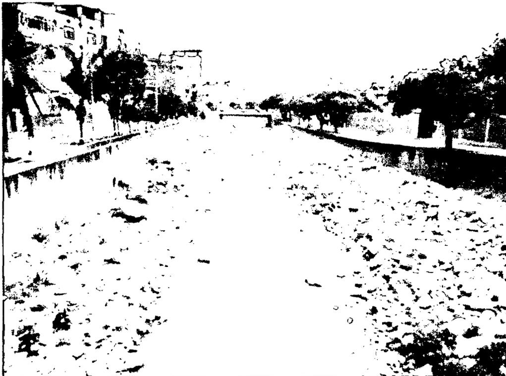
Imagen 06. Tramo del puente M. Muro – puente Manco Capac, la acumulación de sedimentos acorta la sección de la quebrada produciendo en la vista hacia el fondo el 2do punto crítico en el sector Las Brisas, pasando el puente Manco Capac.
