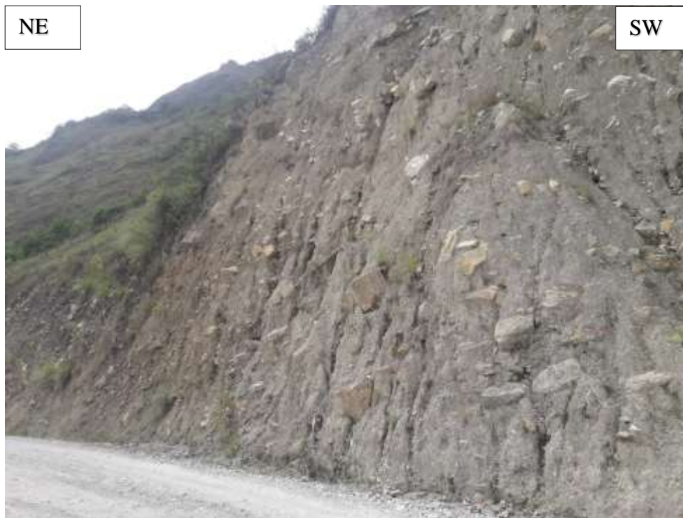
Foto 3.9. Depósito Coluvio-aluvial, ubicado en el flanco derecho de la carretera, conformado por fragmentos de rocas y material englobante de composición limosa de color gris. Coordenadas E: 777612 N: 9265687, cota: 2446 m.sn.m.
