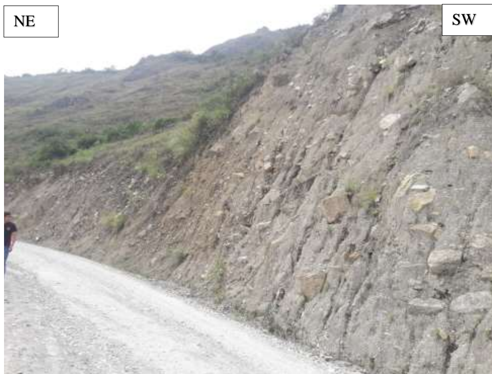
Foto 3.17. Formación de cárcavas en el talud del flanco derecho de la carretera entre la progresiva: Km. 02+500-Km. 02+540. Coordenadas E: 777612 N: 9265687. Cota: 2446 m.s.n.m.
