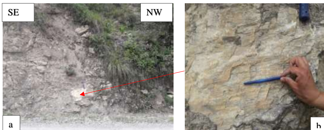
Foto 3.11. a) Se ubica en el flanco derecho de la carretera de la Formación Pariatambo, cubierta por Depósito Cuaternario, aflorando en la parte inferior del talud el plano de falla en la roca caliza, ubicado en la progresiva: Km. 03+950. b) Plano de falla dextral, observándose las estrías de falla, escalones y el movimiento cinemático de la falla.
