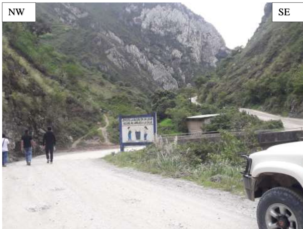
Foto 3.4. Escarpe, ubicado en el puente Obispo. Coordenadas E: 779100, N: 9265000 cota: 2340 m.s.n.m.
