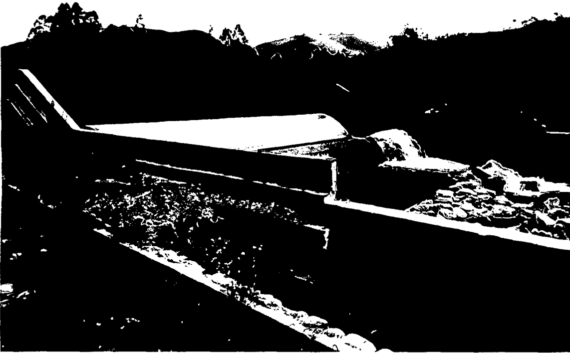
FOTOGRAFIA Nº 01: CAPTACION DEL CANAL DE RIEGO HUAYRAPONGO.
