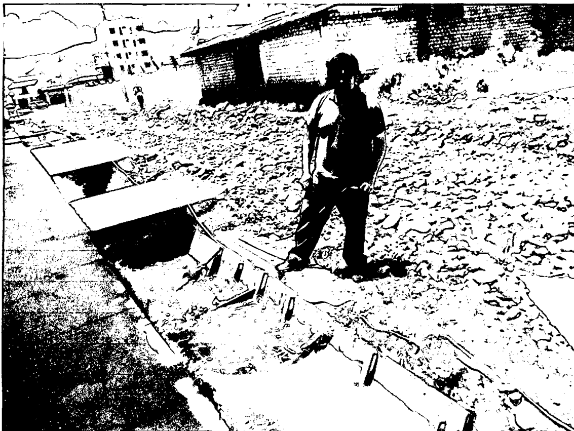
FOTOGRAFIA Nº 32: TRAMO DEL CANAL QUE SE ENCUENTRA REPARADO PROG. 0+934.00
