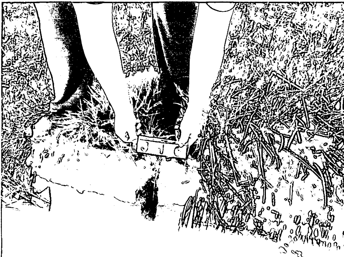
FOTOGRAFIA Nº 30: JUNTA 10, CON EL CODIGO J 10, UBICADA EN LA PROG. 0+492.46
