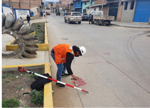
Figura 60. Monumentación de BM, para cambio de estación.
