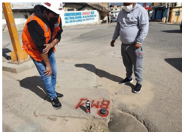
Figura 58. Toma de datos, coordenadas de BM1.
