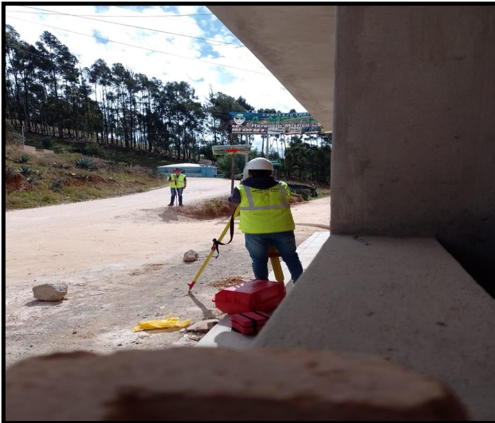
Fotografía N°06: Toma de puntos de borde de vía y desvío
