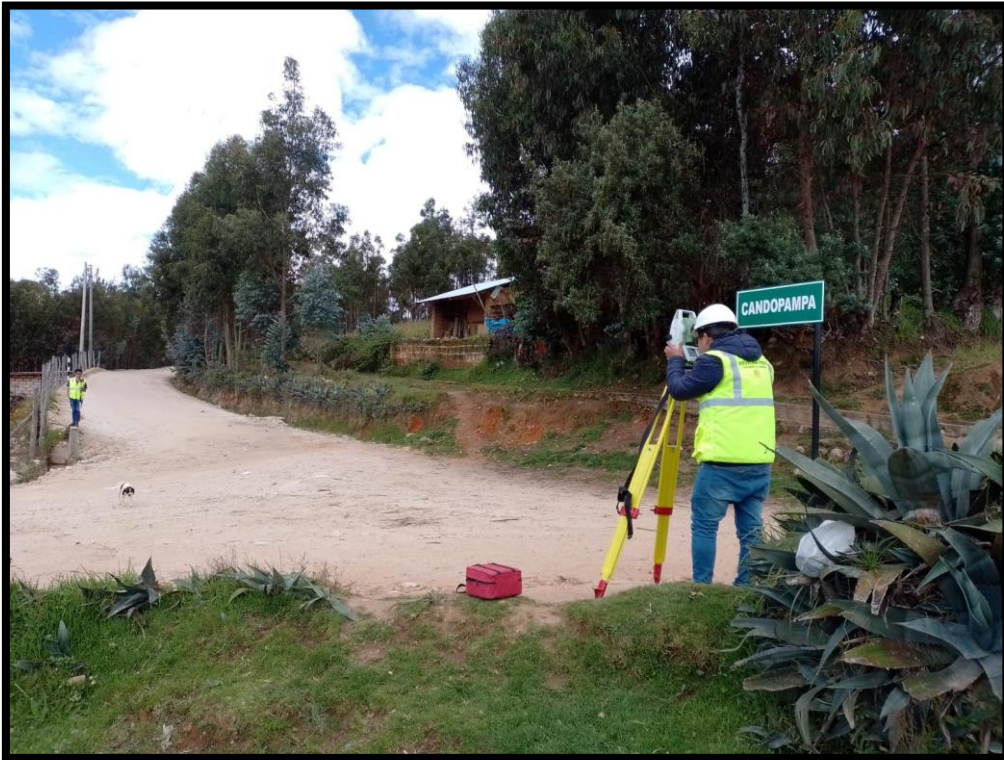
Fotografía N°07: Levantamiento de obras de arte (Alcantarillas)
