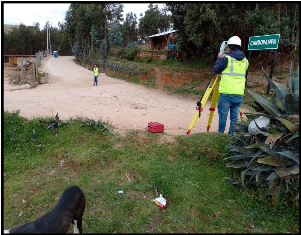
Fotografía N°08: Toma de datos del eje de vía en el final de tramo
