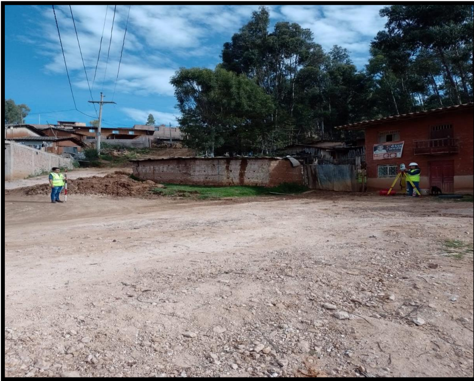
Fotografía N°05: Toma de puntos correspondiente al eje de vía
