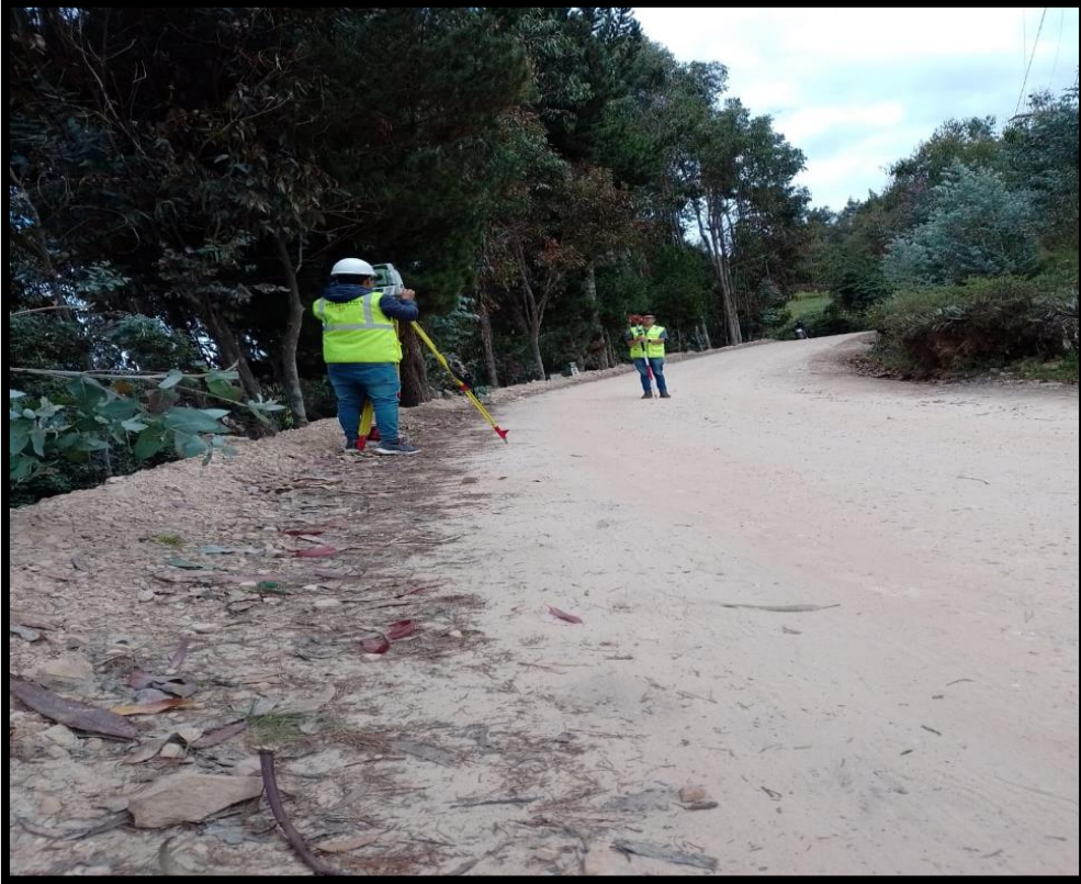
Fotografía N°09: Cambio de estación para el final del tramo km 07+000
