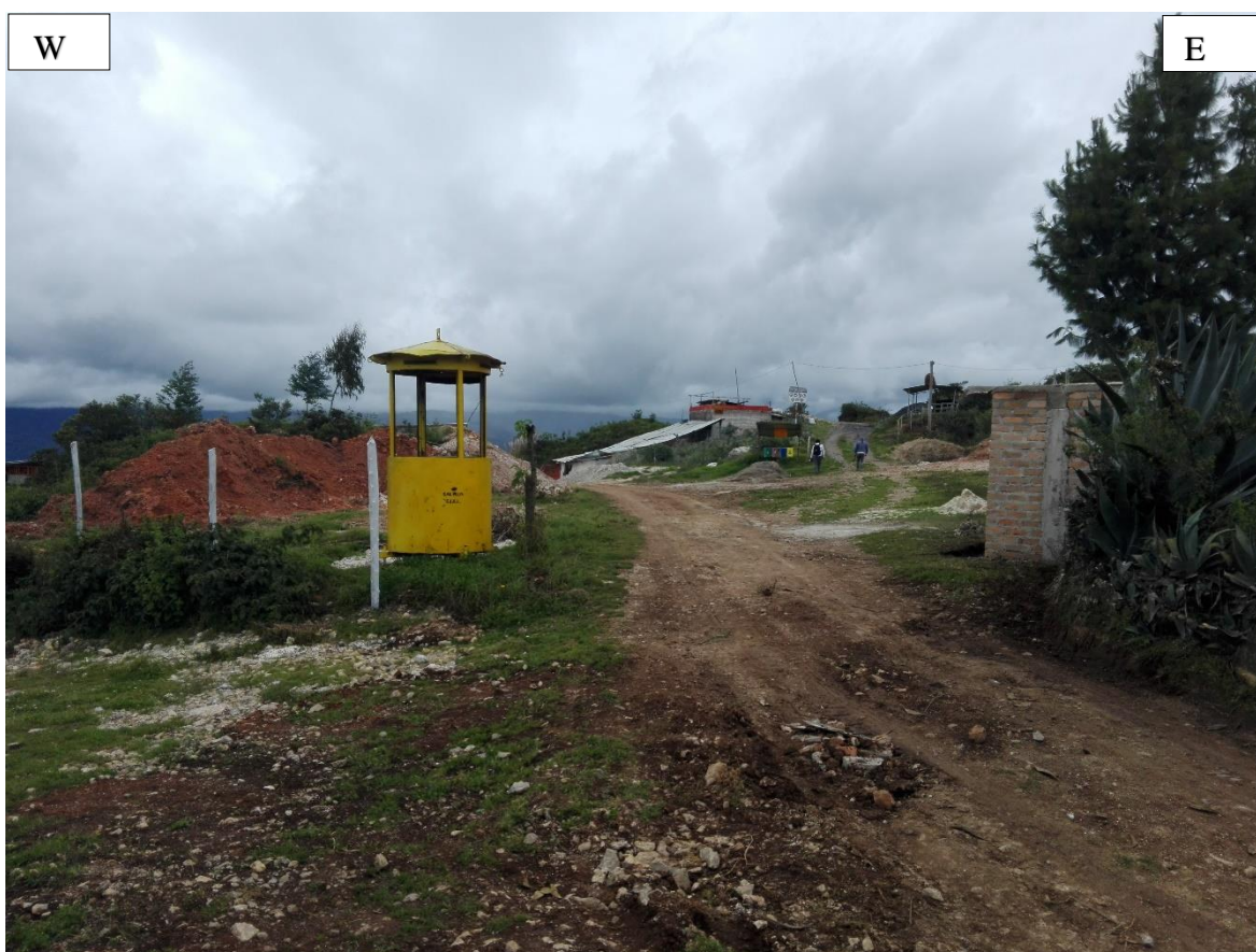
Figura 3.7. Instalaciones del área de beneficio - empresa Cal Plus E.I.R.L., observando la planta metalúrgica, emplazada en la unidad geomorfológica - planicie. Ubicación: E = 769866.849 m., N = 9255532.829 m. y Cota = 3289 msnm.
