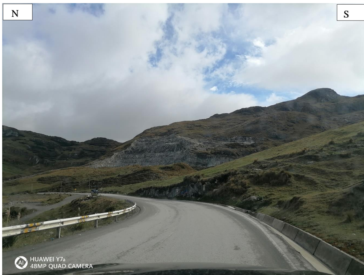
Figura 3.5. Formación Cajamarca se ubicada en el distrito de Hualgayoc, flanco derecho de la carretera. Ubicación: E = 761803.800 m., N = 9249715.030 m. y Cota = 3889 msnm.
