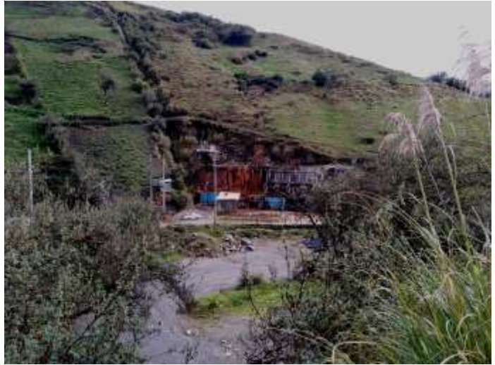
Foto 20. Georeferenciación de viviendas-socavón activo en zona de cultivo de pastos
