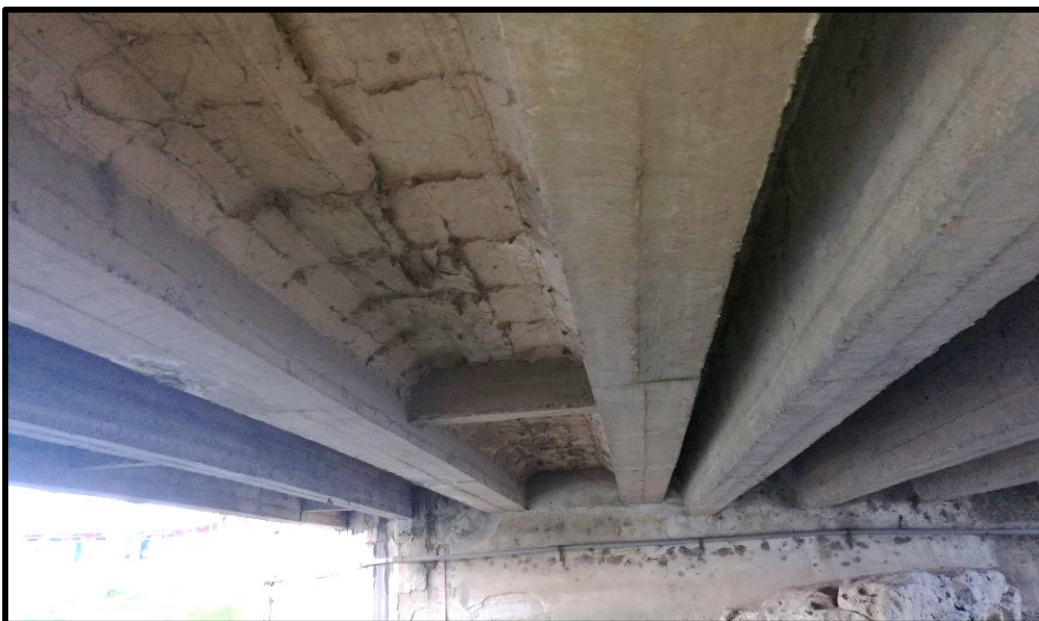
Foto N° 6 : Vista de vigas principales del puente de acceso principal al distrito de Baños del Inca
