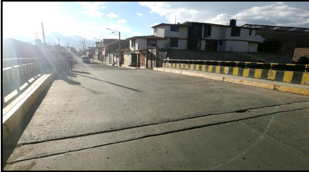
Foto N° 7 : Vista del puente alternativo de acceso al distrito Baños del Inca
