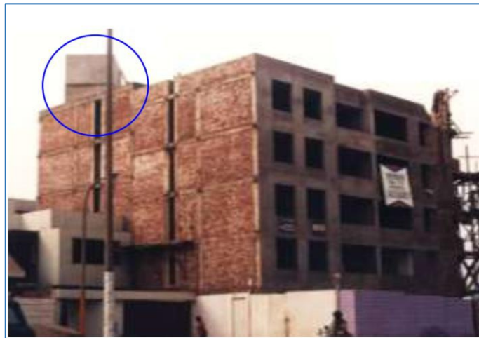
Figura N° 7. Concentración de masas (tanque elevado)
