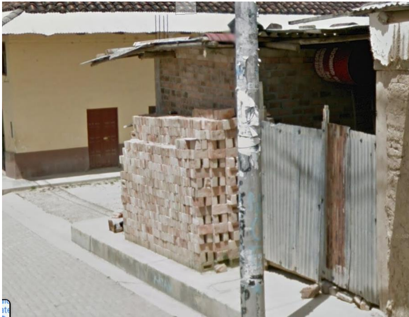
Vivienda con cobertura flexible, sin juntas en los alféizar ni columnetas
