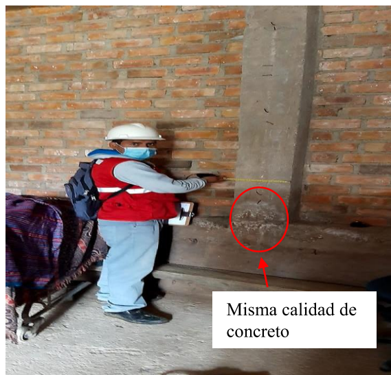
Concreto utilizado en el sobrecimiento y columna
