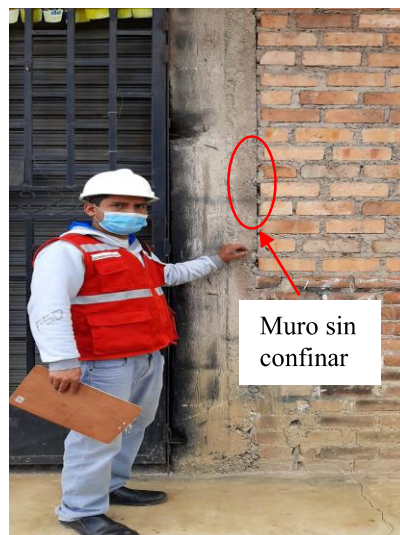
Tabiques sin columnetas y alfeizar sin junta
