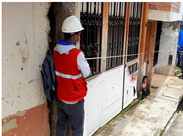
Medida de la fachada de la vivienda
