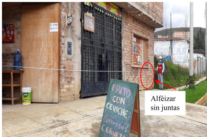
Tabiques sin columnetas y alfeizar sin junta
