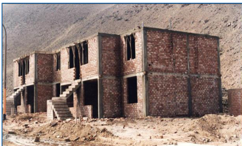
Figura N° 5. Edificio con estructura de albañilería confinada.
