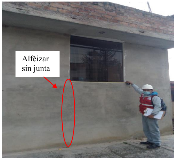
Tabiques sin columnetas y alféizar sin junta
