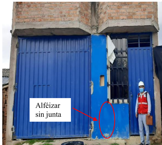
Exposicion del acero y alfeizar sin juntas
