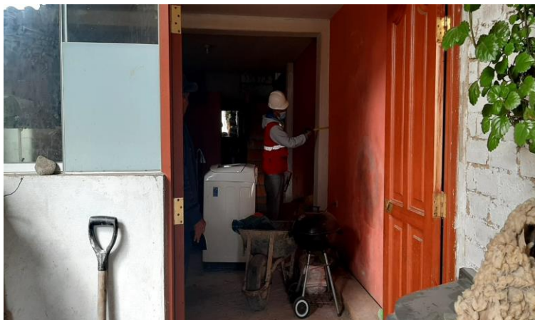
Medida de la viga peraltada en el interior de la vivienda
