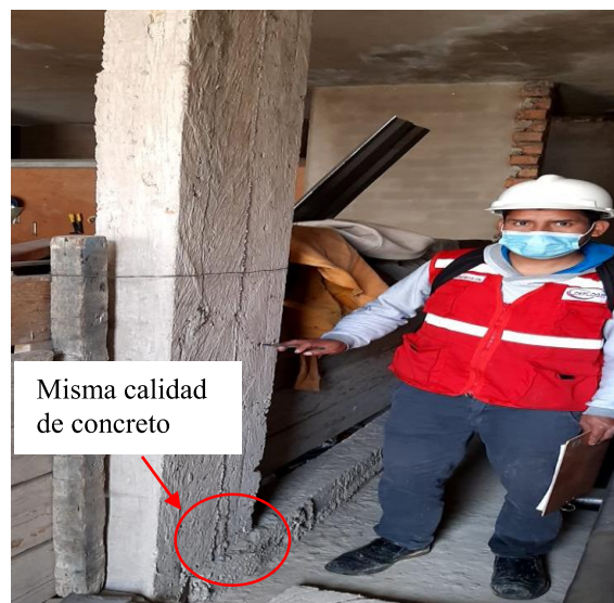
Concreto utilizado en sobrecimiento el mismo de la columna
