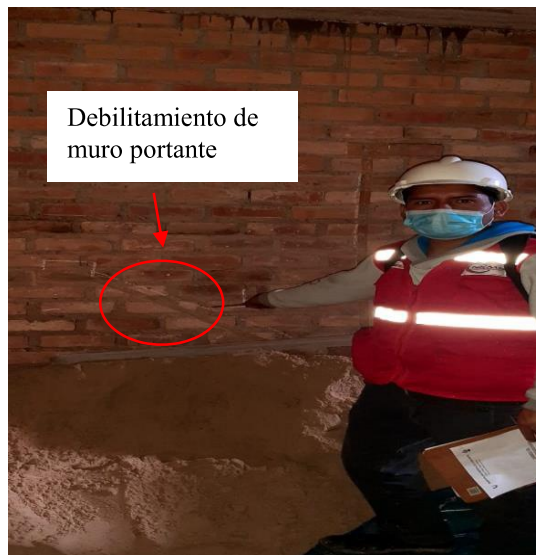
Grosor de junta mayor de 15 mm
