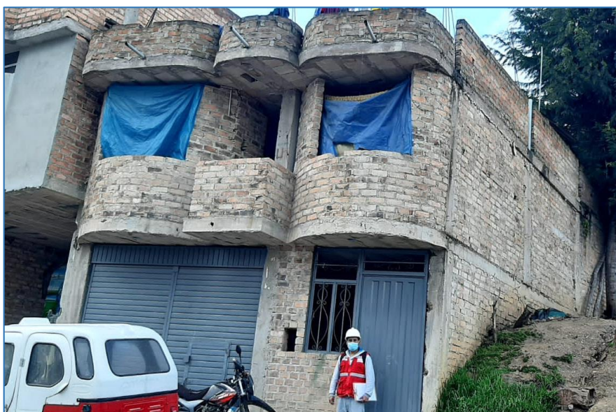
Figura N° 1. Vivienda autoconstruida en el Centro Poblado Puyllucana
