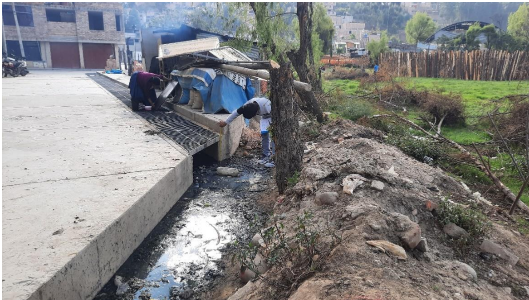
Figura 14: Final del canal de concreto armado, su base está bajo el nivel del agua.
