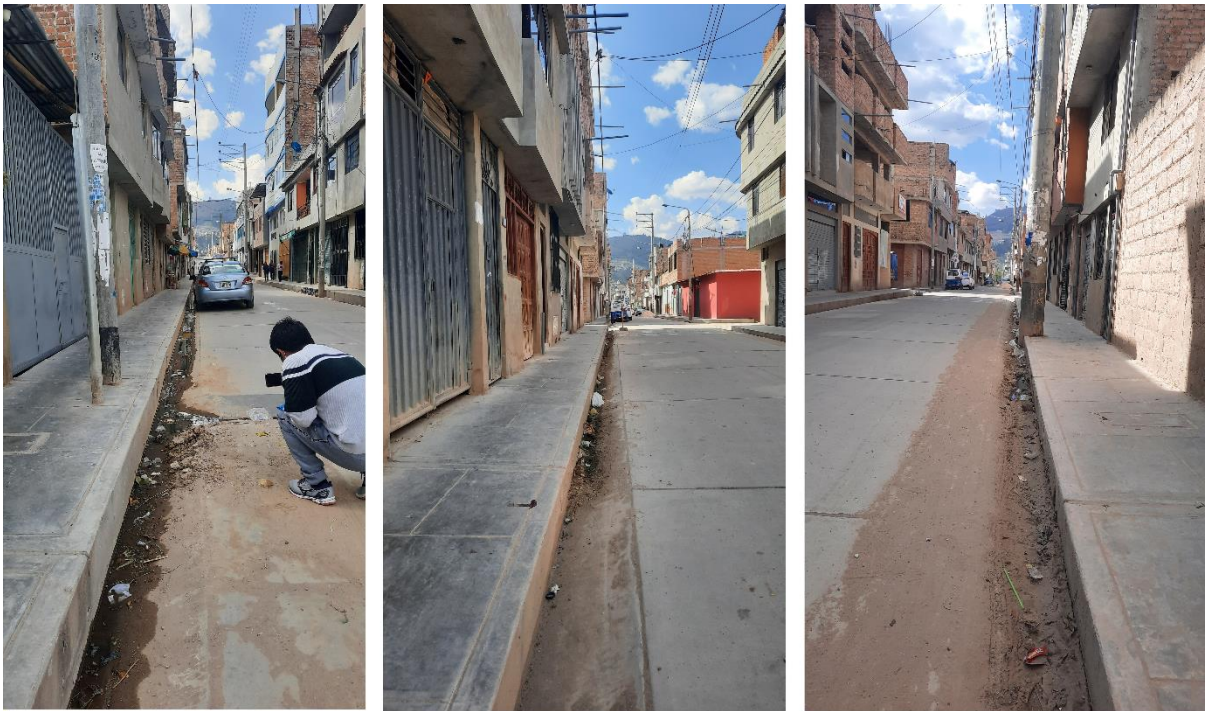
A.4. Existencia de sedimentación en las cunetas de la calle Alemania C1, C2 y C3.
