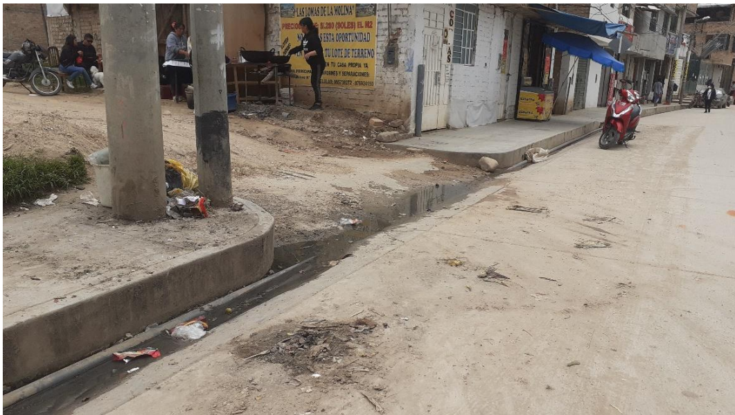
Figura 10: Tubería PVC 2” instalada en la cuneta.
