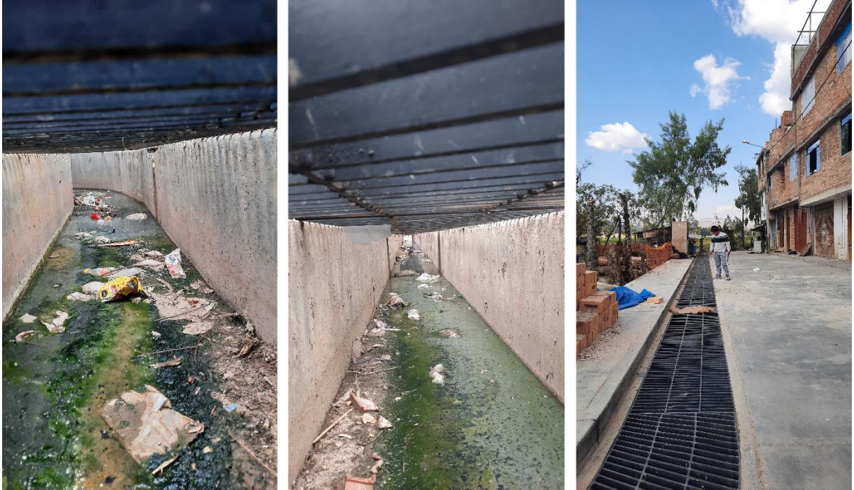
A.4. Existencia de sedimentación en las cunetas de la calle Alemania C1, C2 y C3.
