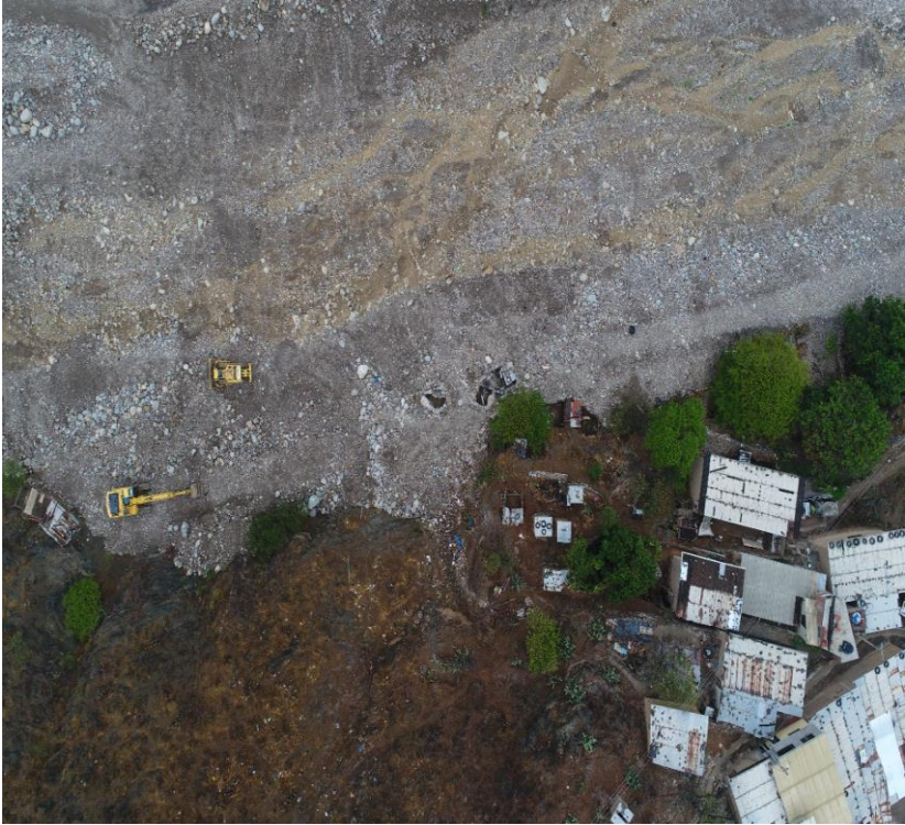
Figura N.º 62: Limpieza de Sedimentos transportados por máximas avenidas.
