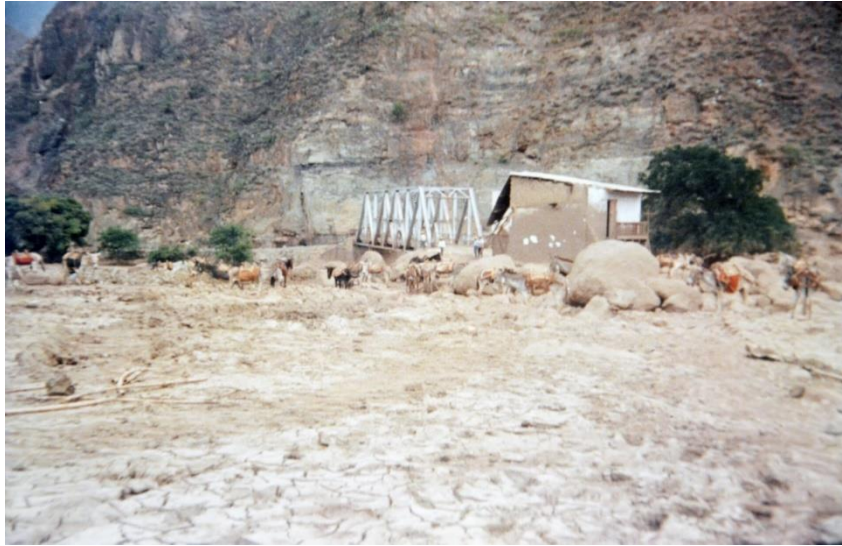
Figura N.º68 : Puente antigua y los sedimentos después de la inundación. Casas destruidas.
