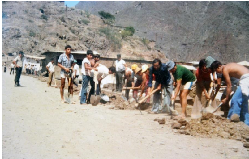
Figura N° 67: Pobladores realizando limpieza después de la inundación.
