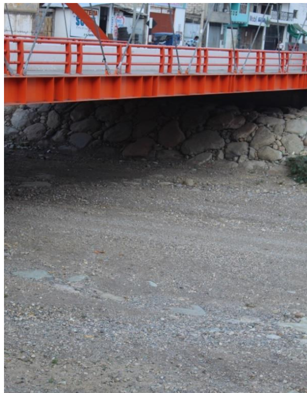
Figura N.º 56: Base del Puente.
