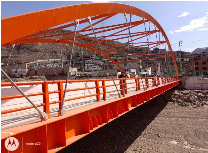
Figura N.º 57: Puente Chilete Antes de llegar a la zona urbana.
