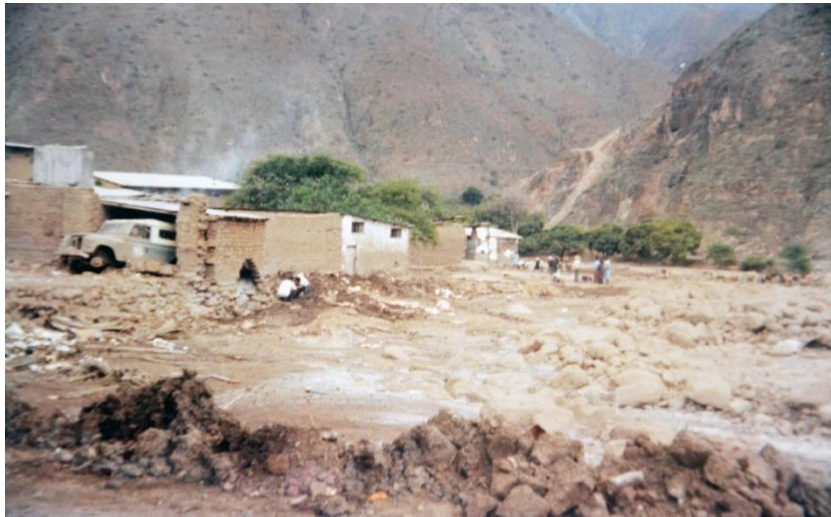
Figura N.º69 : Rocas acareados por el deslizamiento y edificaciones de adobe caídos. Puente antigua y los sedimentos después de la inundación. Casas destruidas.
