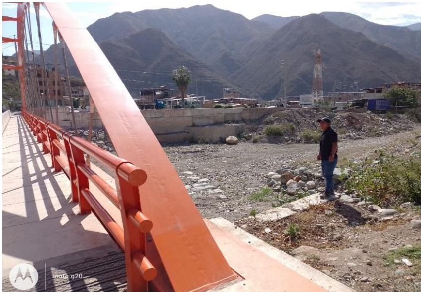
Figura N.º 58: Cauce de la Quebrada aguas abajo del Puente Chilete.
