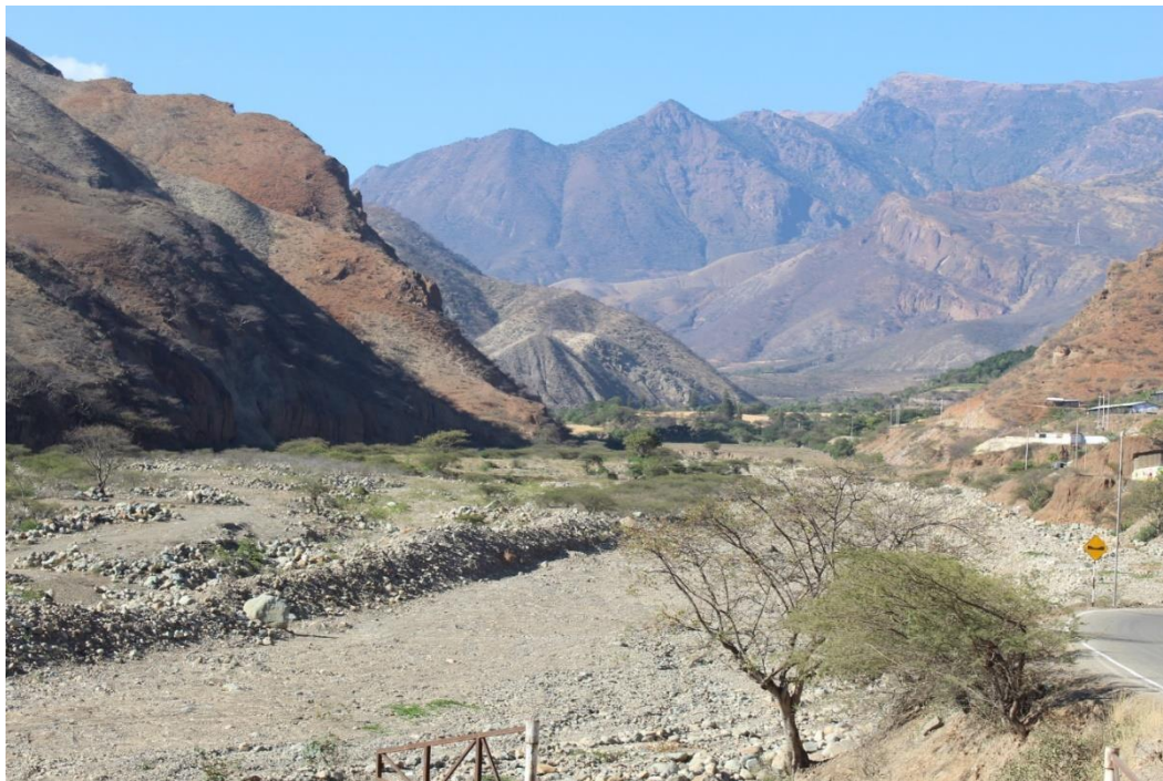
Figura N.º 19: Vista Panorámica de la Quebrada Huertas-Altura del Muro Concreto
