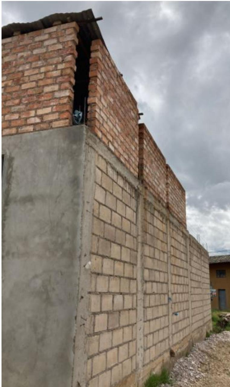
En esta fotografía se puede observar la falta de confinamiento en los muros del segundo nivel de la vivienda N°48, estos muros son de una altura considerable y representan un riesgo ante un evento sísmico.
