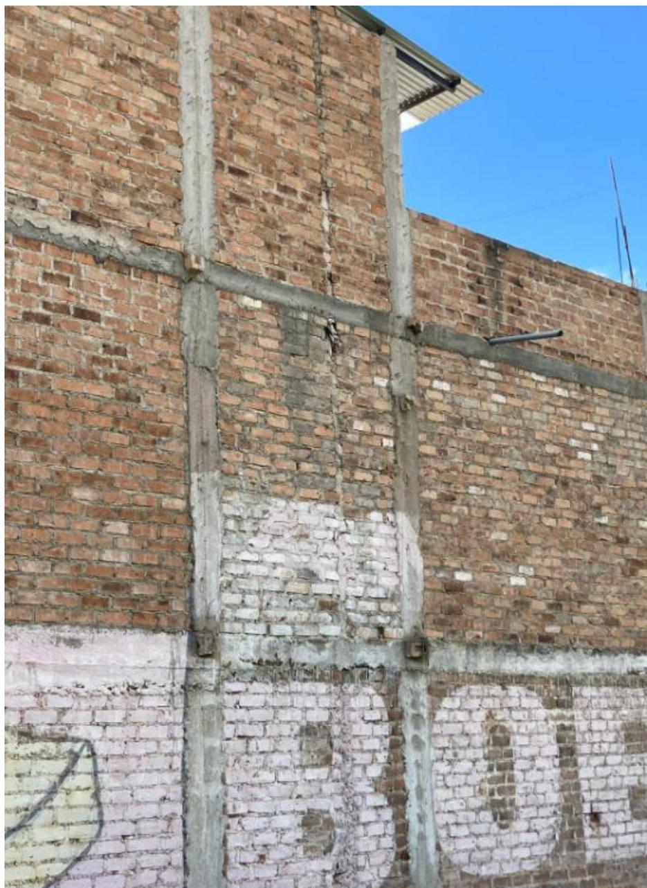
Esta fotografía muestra la causa de la grieta vertical en la fotografía anterior. Como se puede observar, el tubo de 2 pulgadas no cuenta con el confinamiento necesario.
