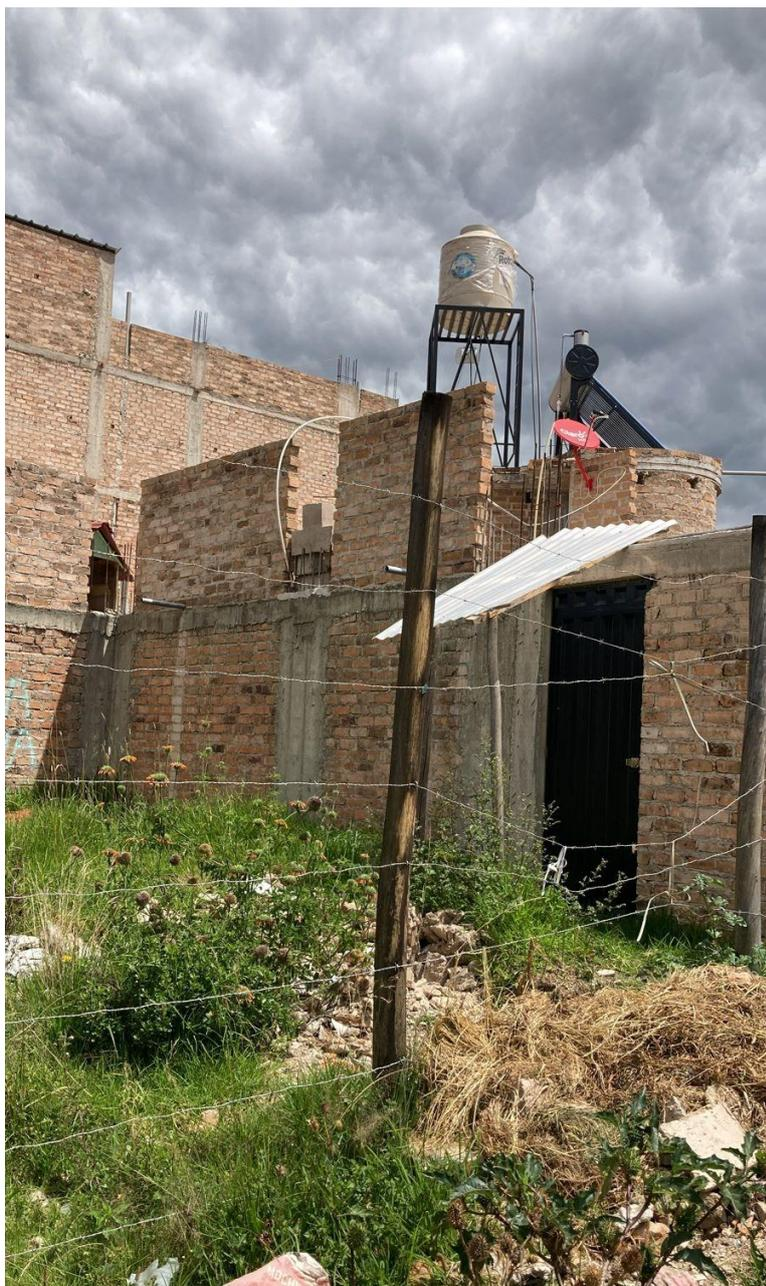
En esta fotografía se puede observar la presencia de muros de gran altura en el segundo nivel de la vivienda N° 34 que no contaban con el confinamiento necesario, siendo estos un riesgo inminente ante un evento sísmico.
