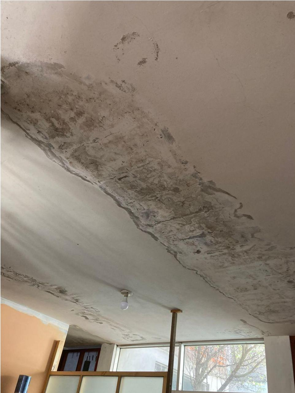
En esta fotografía se puede observar las manchas provocadas por la presencia constante de humedad en el segundo nivel de la vivienda N° 14 debido a que no existe el drenaje correcto de agua de lluvia, lavandería u otros fines. Cabe señalar que esta vivienda consta de un solo nivel construido y se proyecta construir dos niveles más por lo cual el piso del segundo nivel no contaba con el acabado propio de una azotea.
