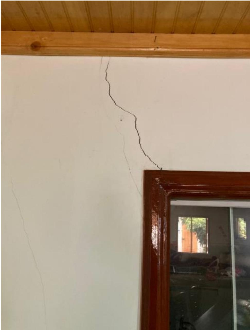
En esta fotografía se puede observar la presencia de grietas en el marco de una ventana de la vivienda N° 50, esta grieta no es solo superficial, sino que atraviesa todo el ancho del adobe que forma la estructura.
