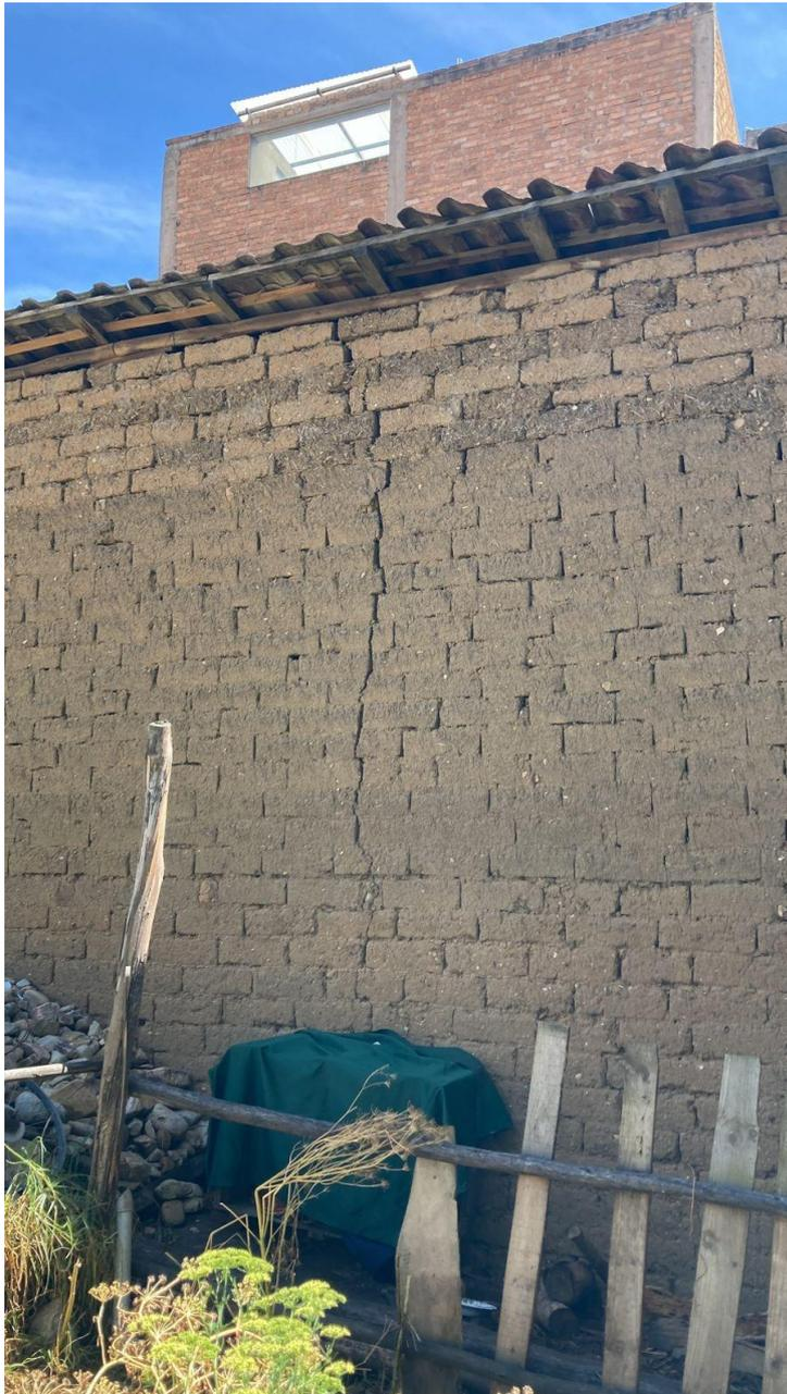
En esta fotografía se puede observar la presencia de una rajadura vertical que compromete la totalidad del muro de adobe de la vivienda N° 107 y la escasa unión entre los bloques que constituyen dicho muro. Esta vivienda sufre además de constantes inundaciones en periodos de lluvia y ha sido identificada con un nivel de Vulnerabilidad Sísmica Muy Alto.
