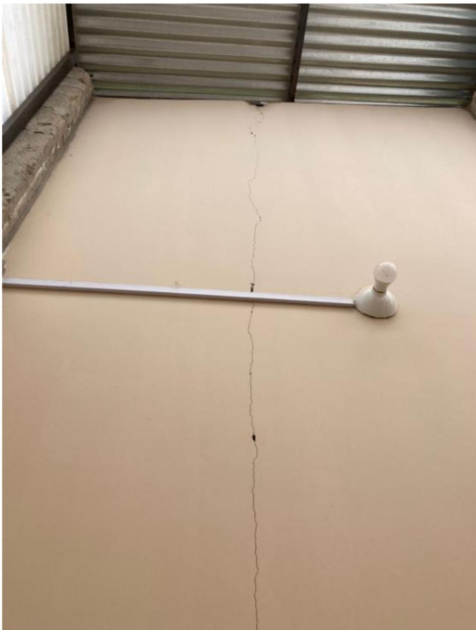
En esta fotografía se puede observar la presencia de una grieta vertical en el muro de la escalera en la vivienda N° 59.
