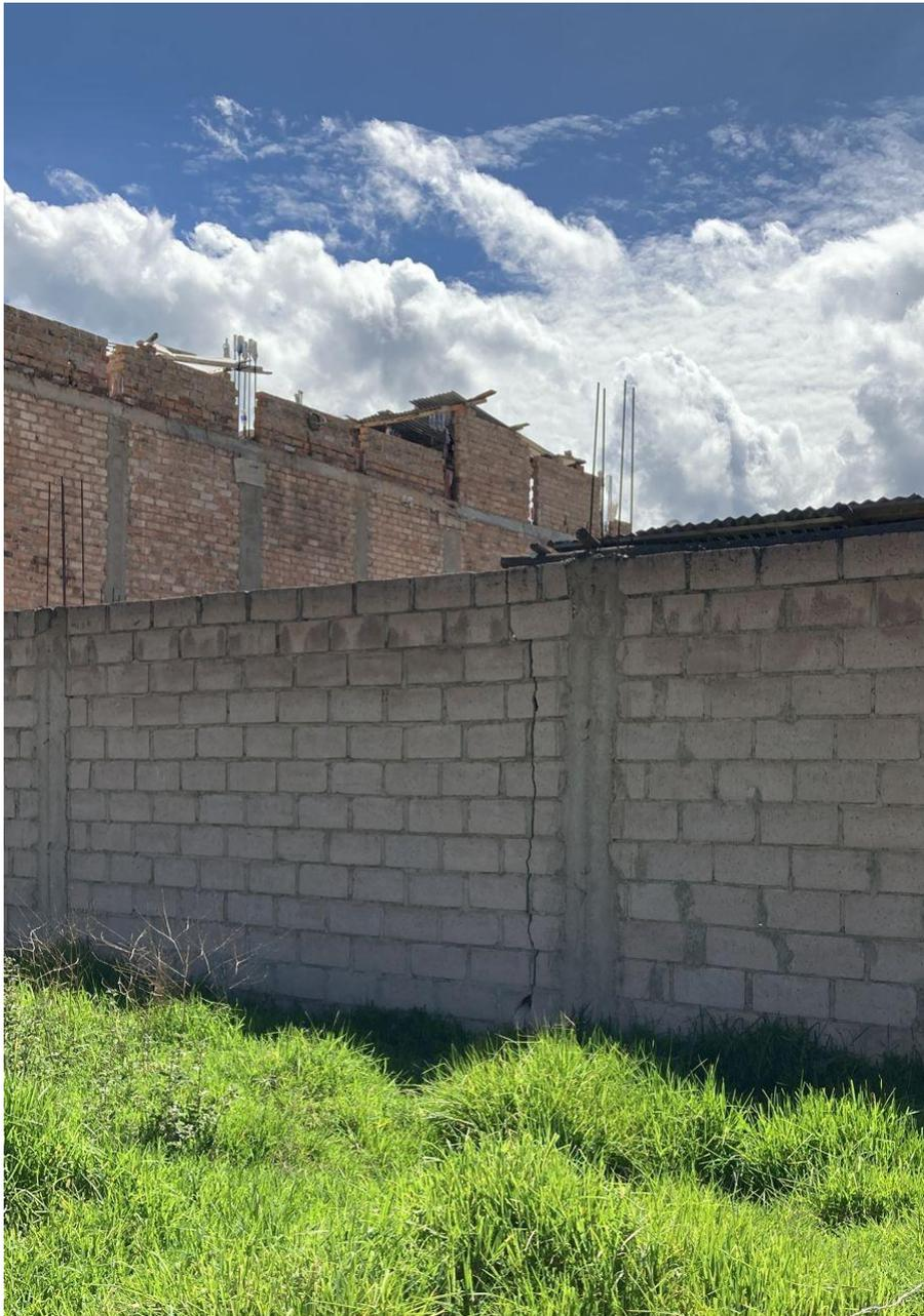
En esta fotografía se observa una rajadura vertical que compromete a toda la altura del muro, esta rajadura es provocada por un asentamiento diferencial del suelo y compromete el funcionamiento del mismo como unidad ante un sismo.
