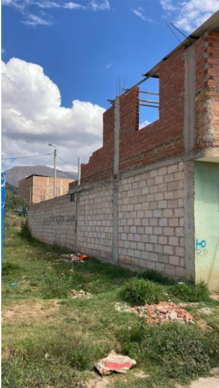
En esta fotografía se puede observar el cambio del tipo de albañilería en una vivienda de albañilería confinada. Se observa en el primer nivel unidades de concreto, en el segundo nivel se observan ladrillos de arcilla artesanal en las cuatro primeras hileras y luego hay un cambio a unidades huecas de arcilla. El aspecto más preocupante en esta vivienda es el uso de ladrillo tipo pandereta en los muros resistentes de una vivienda de muros portantes.
