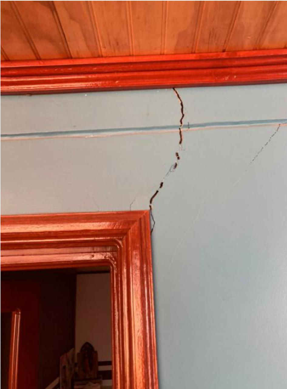
En esta fotografía se puede observar la presencia de grietas en el marco de una puerta de la vivienda N° 50, esta grieta no es solo superficial, sino que atraviesa todo el ancho del adobe que forma la estructura.
