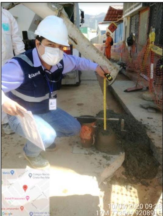
Foto 50. Determinación de la consistencia del concreto.
