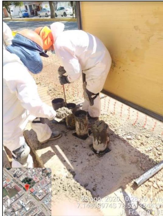
Foto 37. Elaboración de los especímenes de concreto.
