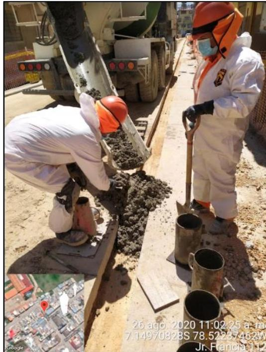
Foto 33. Llenando el cono de Abrams para la determinación de la consistencia.
