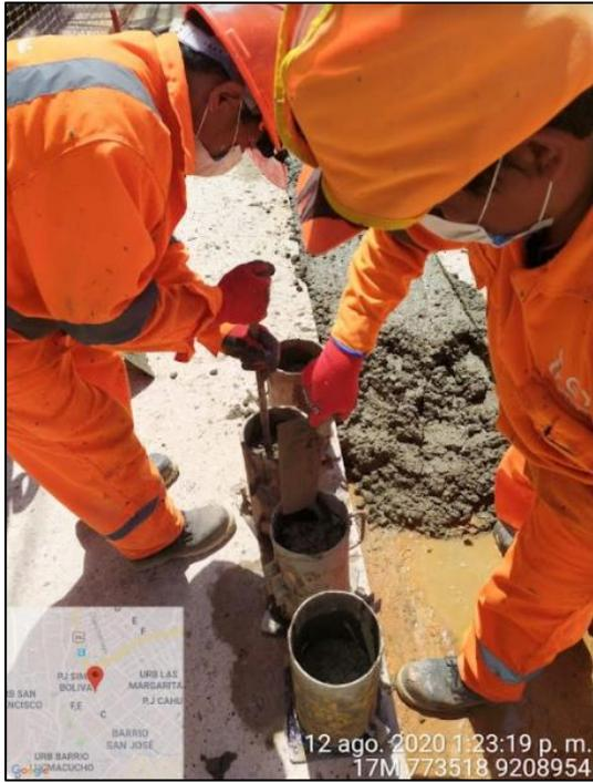
Foto 19. Elaboración de los especímenes de concreto.
