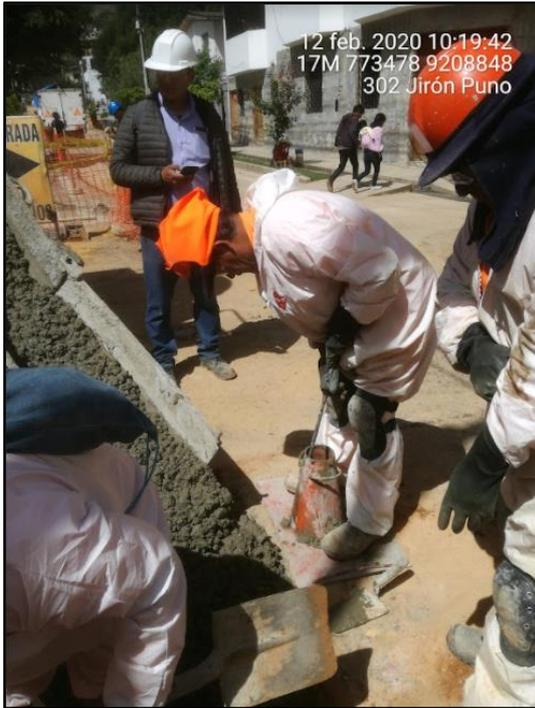
Foto 07. Ensayo de consistencia en su primera capa.
