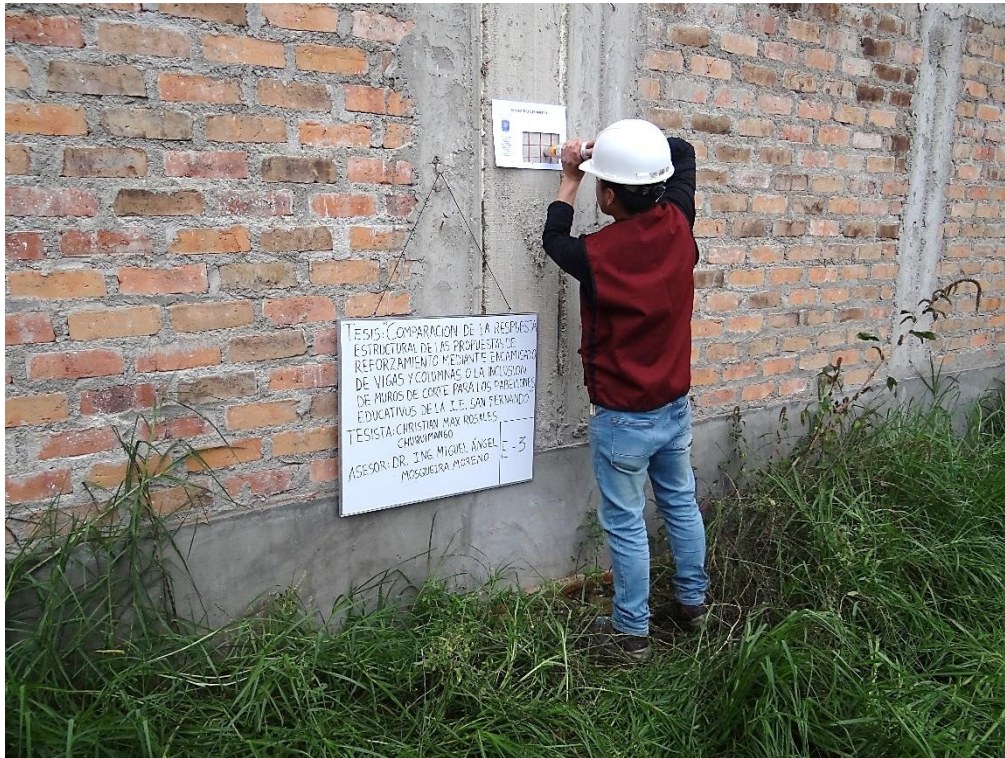
Fotografía N° 3. Ensayo E3 - Columna C1 (Eje 3 - Piso 1).
