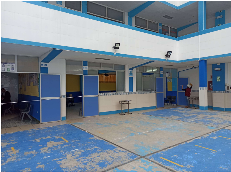
FIGURA 19: TOMA DE MEDIDAS EN EL EXTERIOR DEL PABELLÓN "B"
