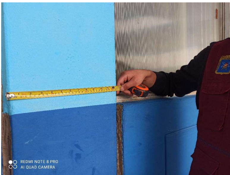
FIGURA 8: TOMA DE MEDIDAS EN COLUMNAS DEL PABELLÓN "B"
