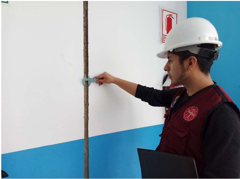
FIGURA 13: TOMA DE MEDIDAS EN LAS JUNTAS DE SEPARACIÓN
