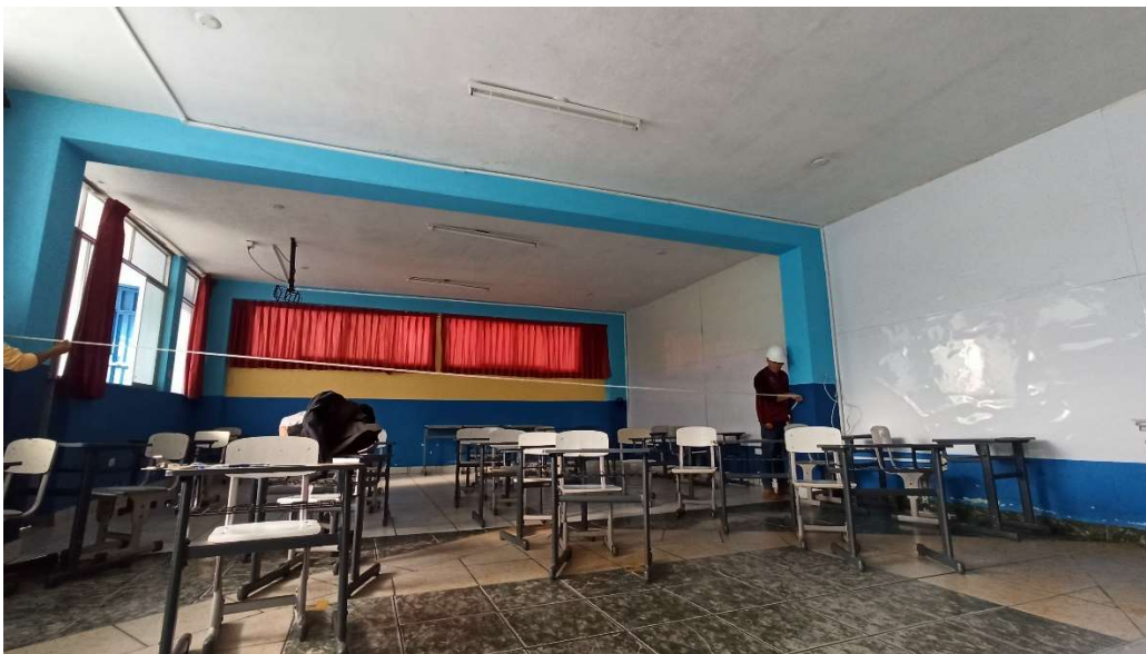
FIGURA 20: TOMA DE MEDIDAS EN EL INTERIOR DEL PABELLÓN "B"
