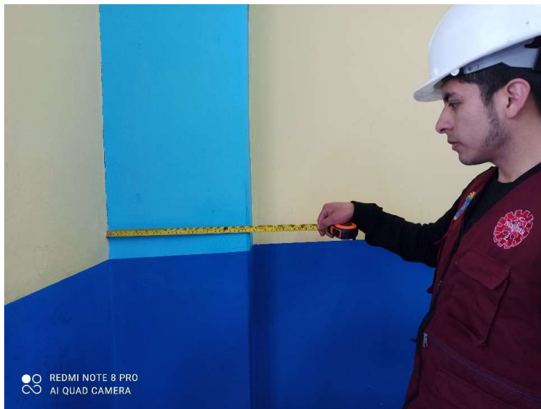
FIGURA 10: VERIFICACIÓN DE MEDIDAS EN COLUMNAS DEL PABELLÓN "B"
