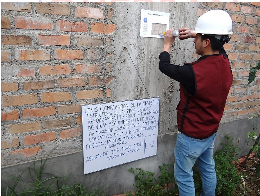
Fotografía N° 2. Ensayo E2 - Columna C1 (Eje 4 - Piso 1).
