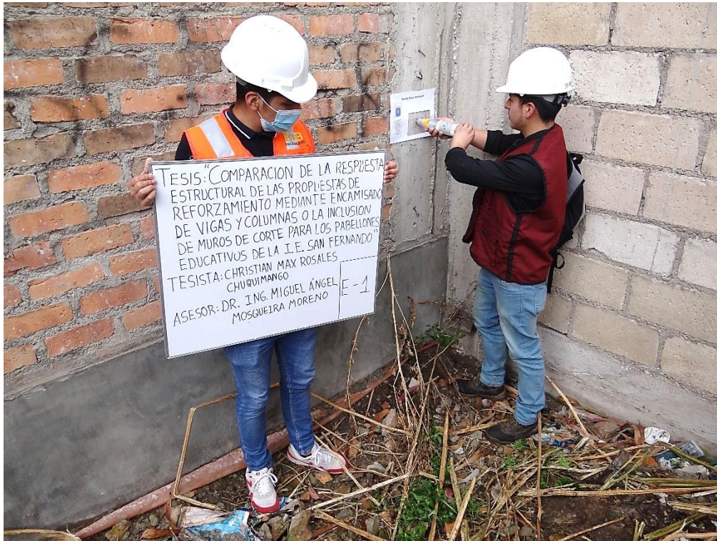
Fotografía N° 1. Ensayo E1 - Columna C1 (Eje 5 - Piso 1).
