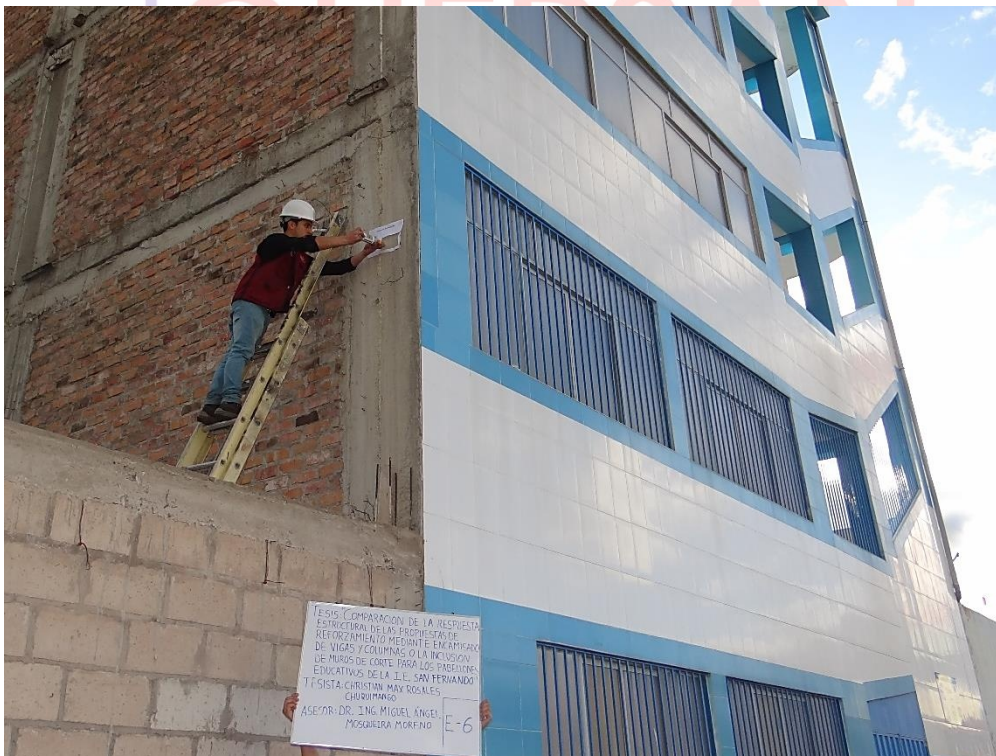
Fotografía N° 6. Ensayo E6 - Columna C1 (Eje 5 - Piso 2).
