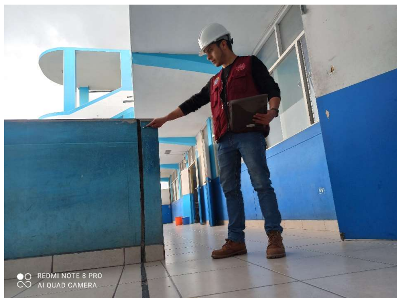
FIGURA 2: VERIFICACIÓN DE EXISTENCIA DE JUNTAS DE SEPARACIÓN ENTRE PABELLONES
