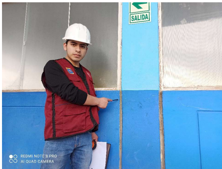
FIGURA 6: VERIFICACIÓN DE JUNTA DE SEPARACIÓN ENTRE MUROS DE ALBAÑILERÍA Y PÓRTICOS
