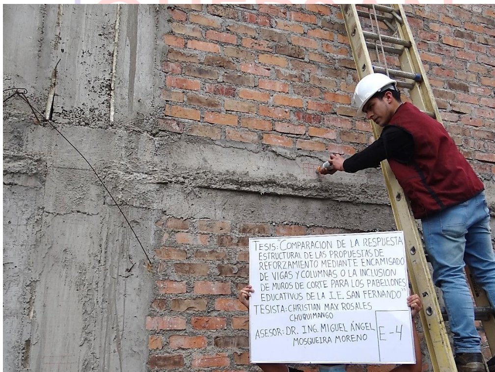
Fotografía N° 4. Ensayo E4 - Viga VA-2 (Eje 4 - 5, Piso 1).
