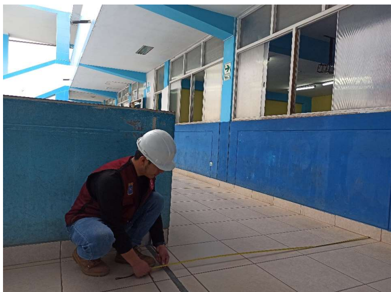
FIGURA 16: TOMA DE MEDIDAS EN VOLADIZO DEL PABELLÓN "B"
