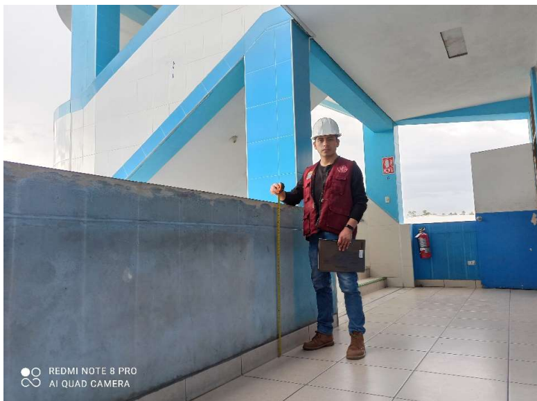
FIGURA 4: TOMA DE MEDIDAS EN PARAPETOS DEL CORREDOR
