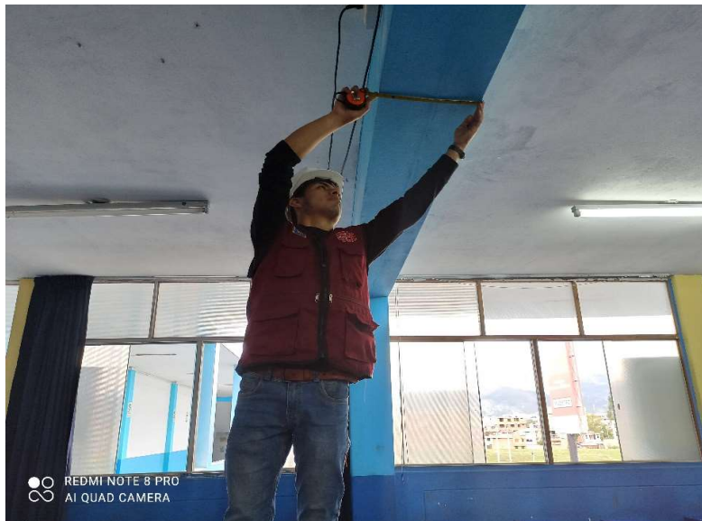
FIGURA 11: VERIFICACIÓN DE MEDIDAS EN VIGAS PRINCIPALES
