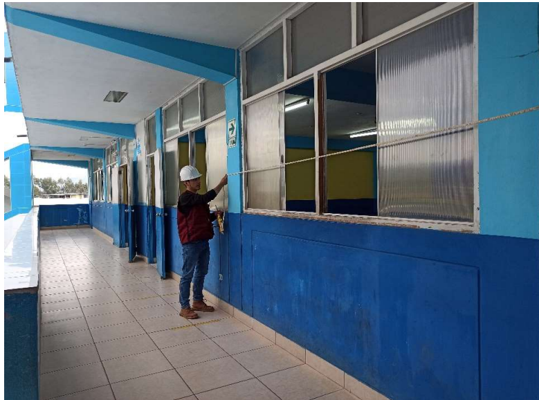
FIGURA 15: TOMA DE MEDIDAS DE DISTANCIA ENTRE COLUMNAS
