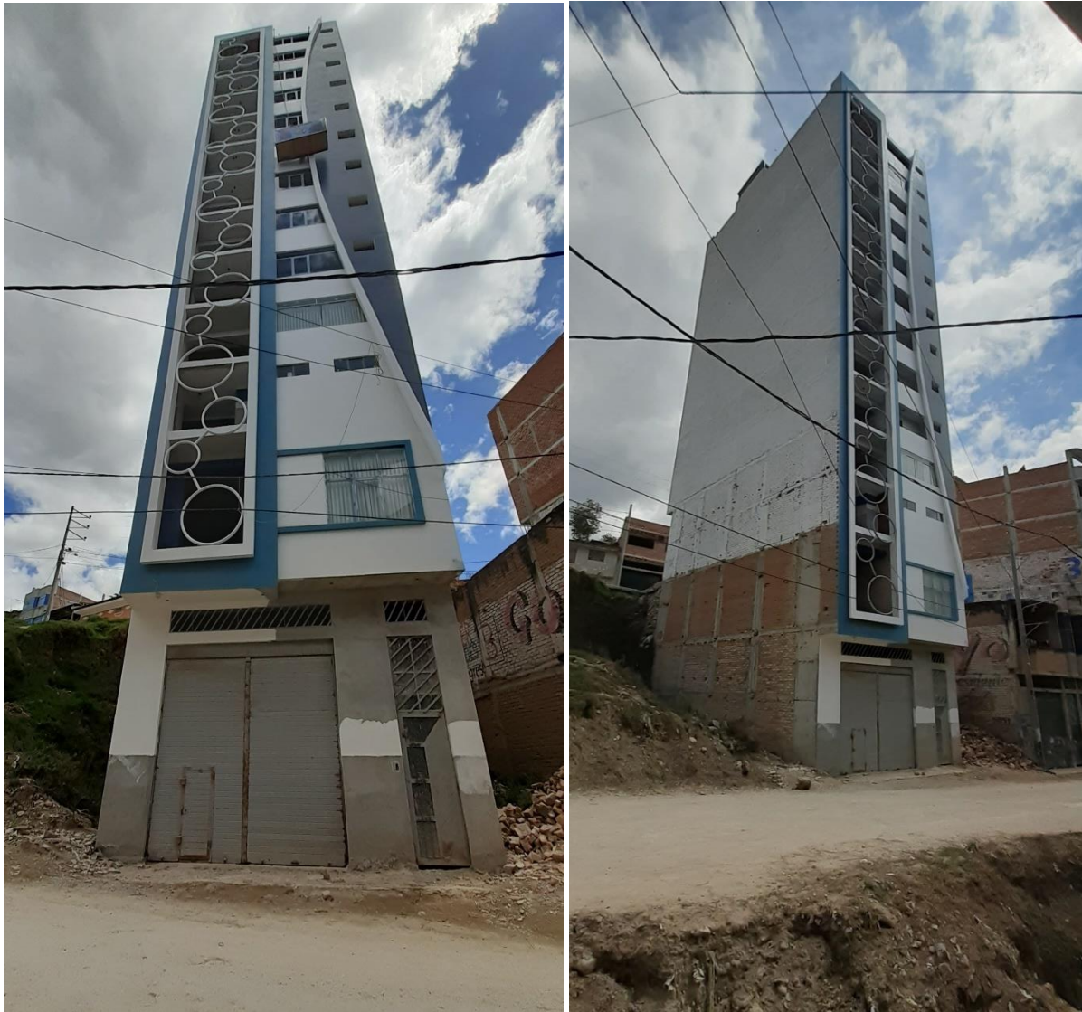
Figura Nº01 y Nº02: Se observa la fachada principal del edificio hacia el Jr. Camino Real.
