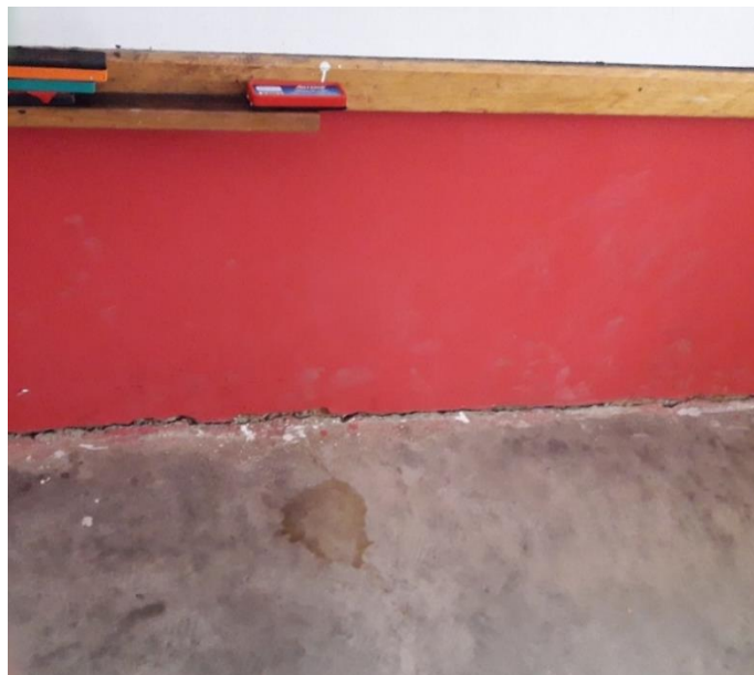
FIGURA 29. Separación por incompatibilidad de materiales en muros de tapial de la I.E.P. “San Isidro”.
