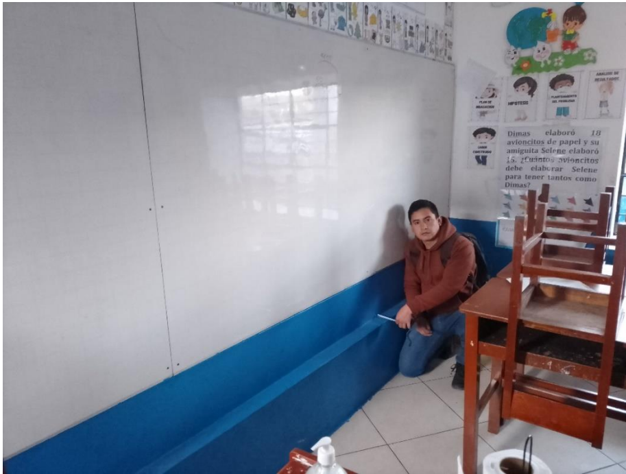
FIGURA 34. Muro de ladrillo sobre muro de tapial en la I.E.P. “Nuestra Señora de Fátima”.
