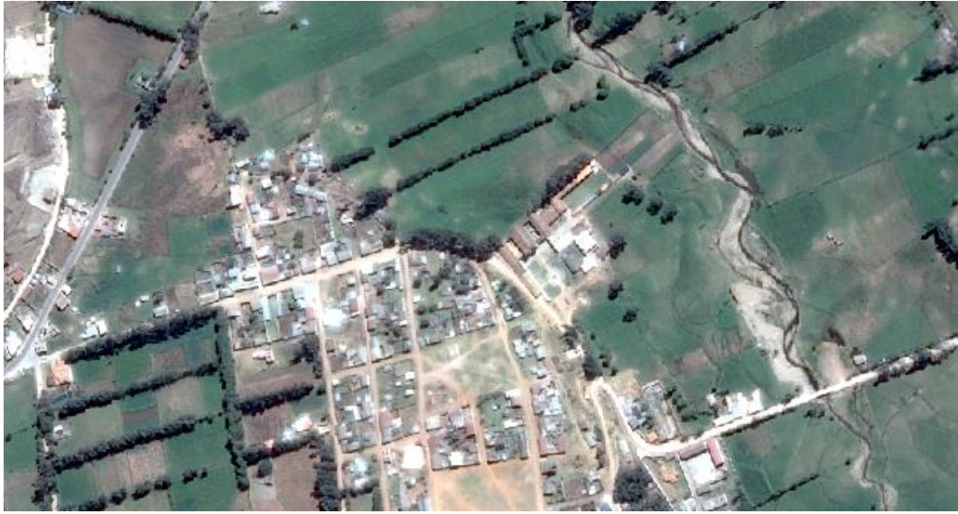
Figura 46. Viviendas expuestas a inundaciones del río La Encañada.
