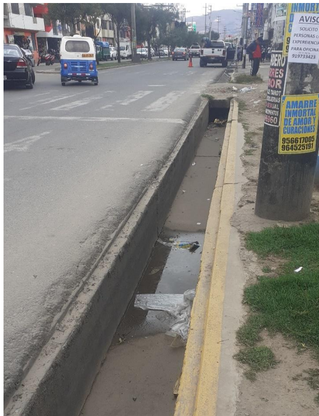
Fotografía N° 20: Cuneta rectangular del tramo 2, dirección de viaje B
