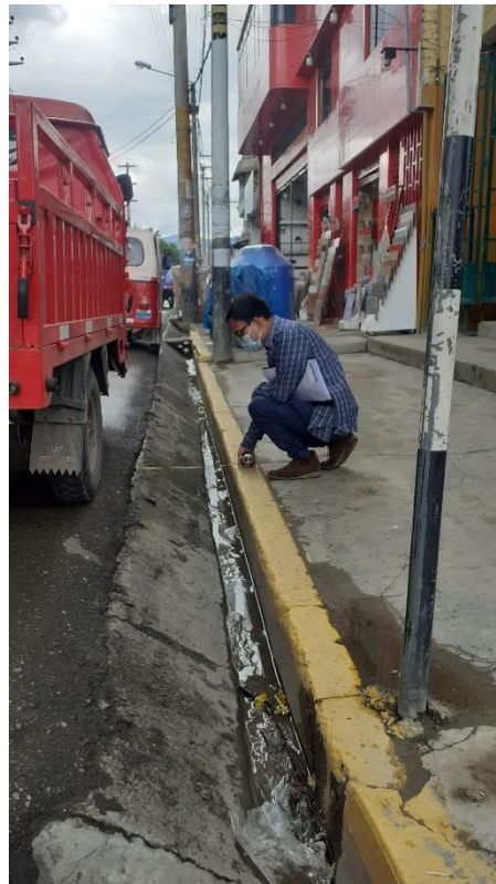
Fotografía N° 4: Toma de medidas de la cuneta del segmento 3
