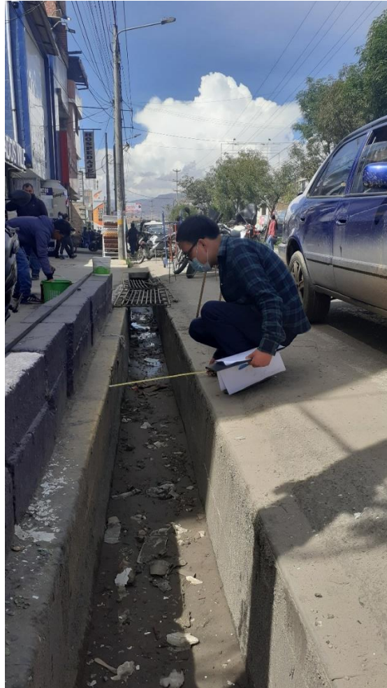
Fotografía N° 5: Toma de medidas de la cuneta del segmento 2
