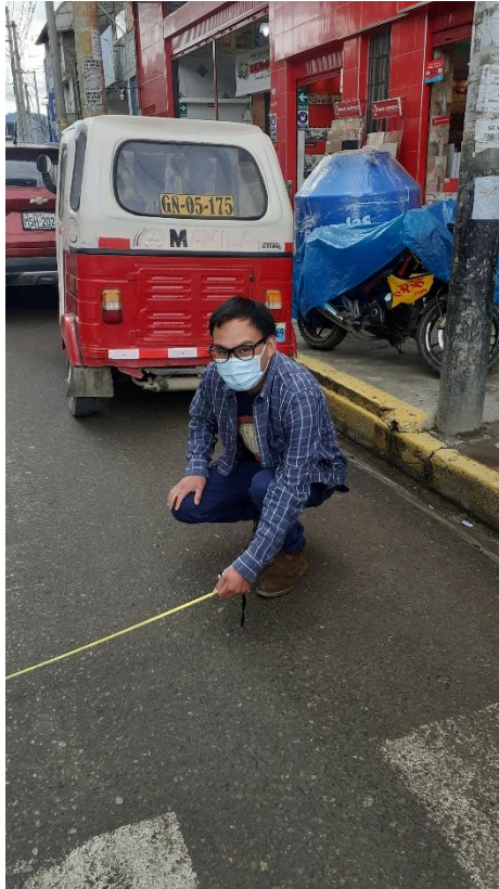
Fotografía N° 3: Toma de medidas de la calzada del segmento 3
