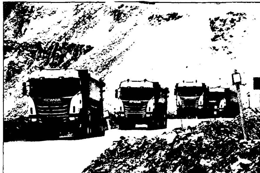
Foto 06. Acarreo de material
