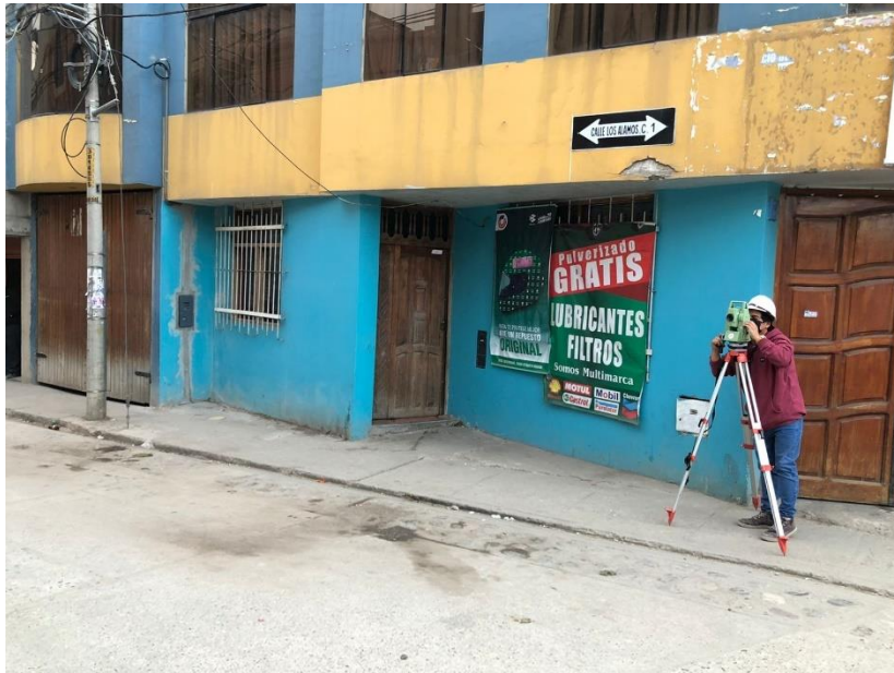
Fotografía N°63:Levantamiento topográfico calle Los Álamos Cuadra 01
