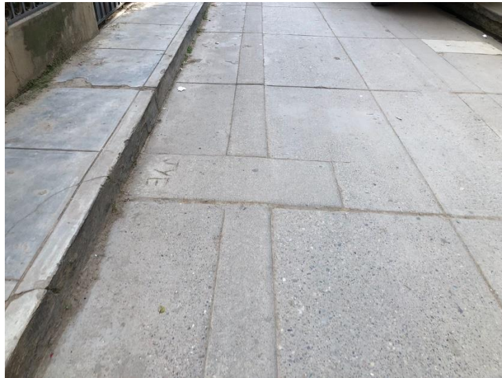
Fotografía N°27:Tramo 05 UM – 11 Parcheos pequeños y grandes a lo largo de toda la vía
