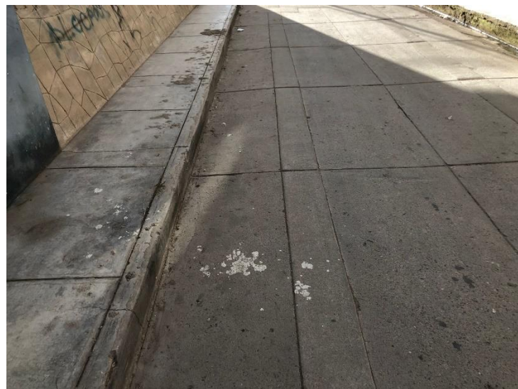
Fotografía N°28:Tramo 05 UM – 12 Presentación de Popouts
