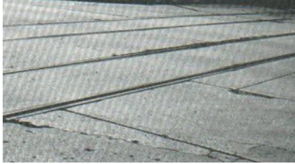
Fotografía N°15: : Vista típica de un cruce de vía férrea de baja severidad.
