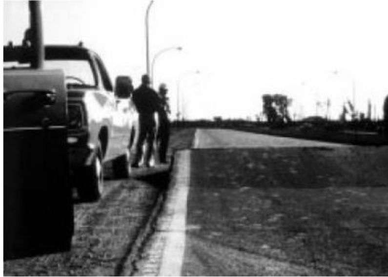
Fotografía N°01: Levantamiento de pavimento rígido de alta severidad
