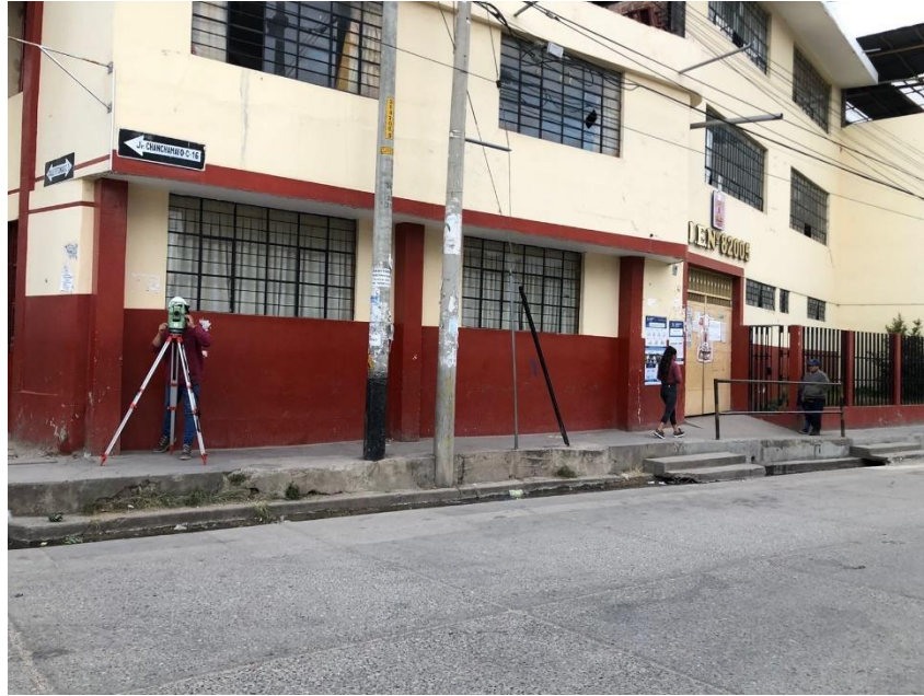
Fotografía N°64: Levantamiento topográfico calle Chanchamayo Cuadra 16
