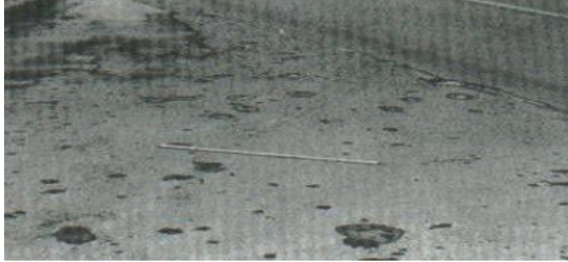
Fotografía N°12: : Vista típica de Popouts
