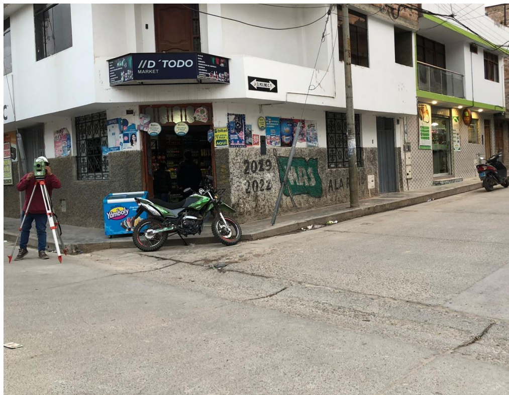
Fotografía N°66: Levantamiento topográfico calle El Molino Cuadra 01
