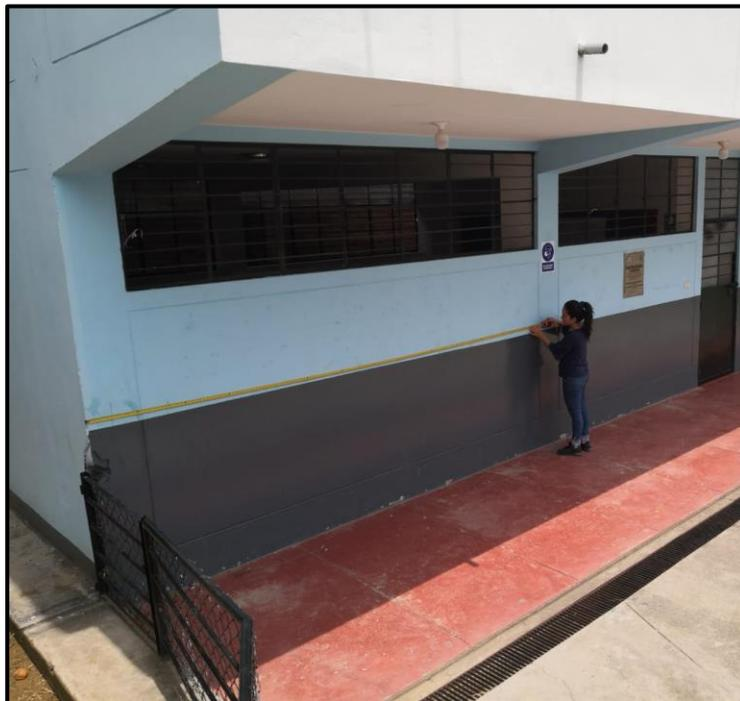
**Foto 6:** Verificación de las medidas de los ejes de columna a columna
