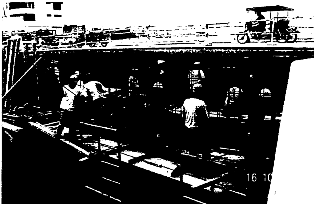
Figura 28. La vista muestra la deflexión del acero y parte del encofrado que ha sido arrancado por el cauce del río, afectando la estructura agua.
