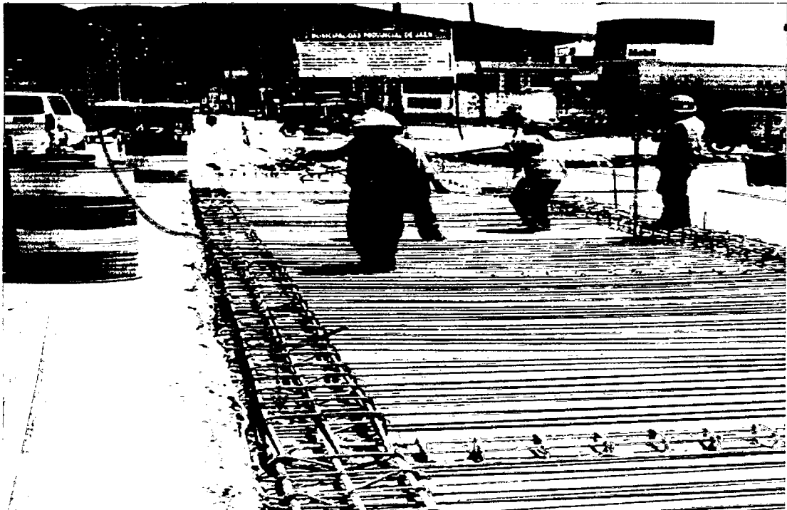
Figura 32a. Se muestra acero colocado en las vigas longitudinales.
