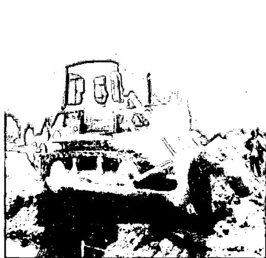
**FIGURA 17,18:** En esta vista se ve el corte de material duro con tractor oruga (D6) y excavadora, respectivamente.
