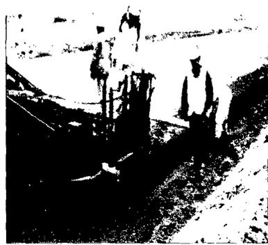
**FIGURA 11,12:** Se ve el colocado del material granular de base o subbase granular
