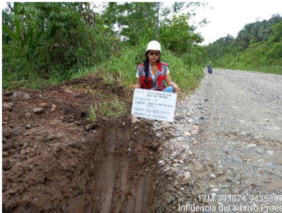
Fotografía 11: Ejecución de la calicata 07 lado izquierdo de la vía, con una profundidad de 1.50 m.
