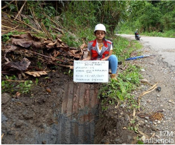
Fotografía 09: Ejecución de la calicata 04 lado izquierdo de la vía, con una profundidad de 1.50 m
