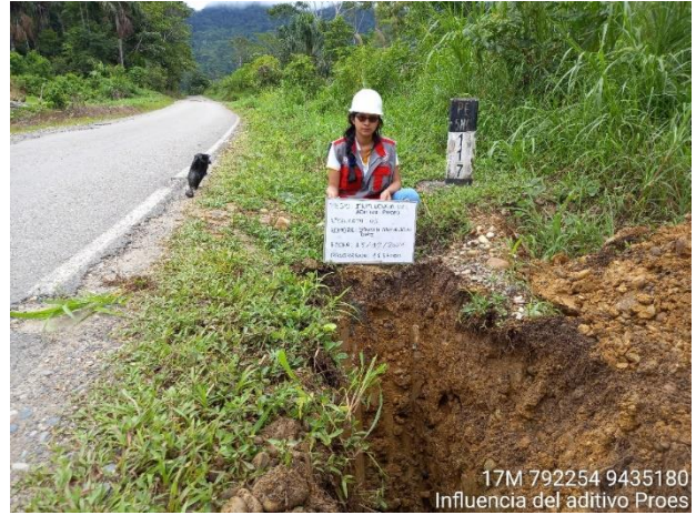
Fotografía 10: Ejecución de la calicata 05 lado derecho de la vía, con una profundidad de 1.50m
