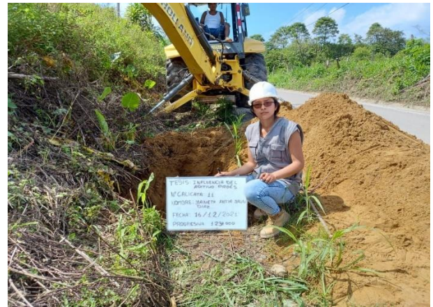
Fotografía 12: Ejecución de la calicata 07 lado izquierdo de la vía, con una profundidad de 1.50 m.
