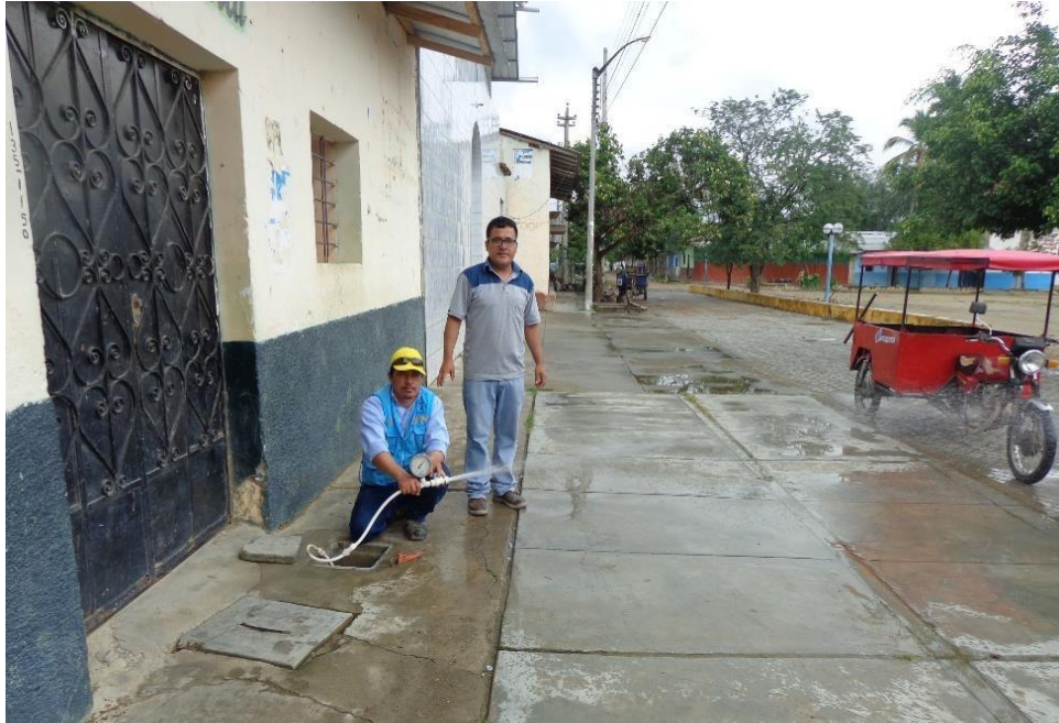
FIGURA 38: Medición de presión de agua con manómetro, Localidad de Bellavista.
