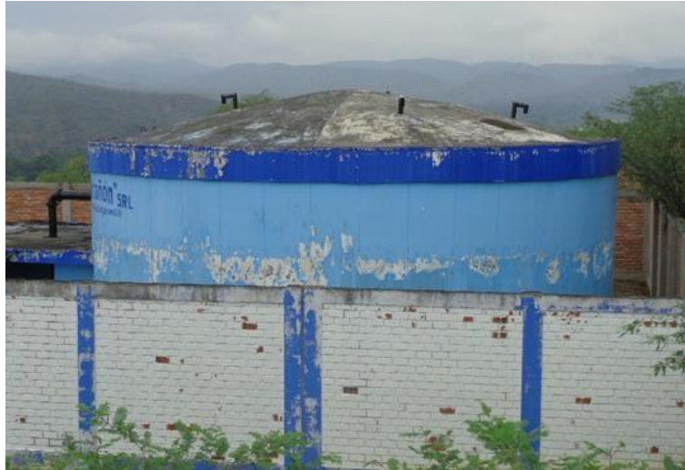
FIGURA 4: Estructura existente del reservorio de 600 m 3 de capacidad, Bellavista.
