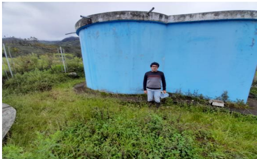
Fotografía 19 Vista del reservorio N°03
