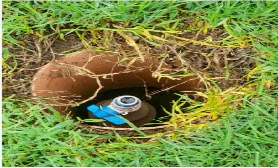
Fotografía 17 Vista del Reservorio N°01
