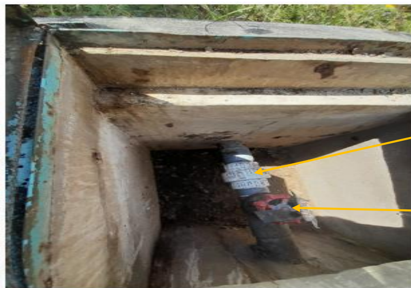
Fotografía 4 Vista de la cámara seca de la captación "Alto Mirador"
