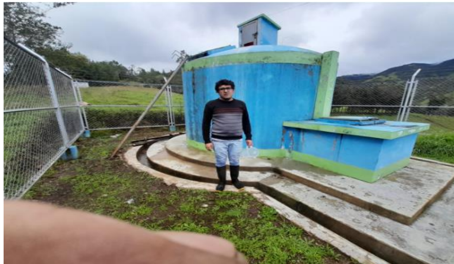
Fotografía 18 Vista del reservorio N°02
