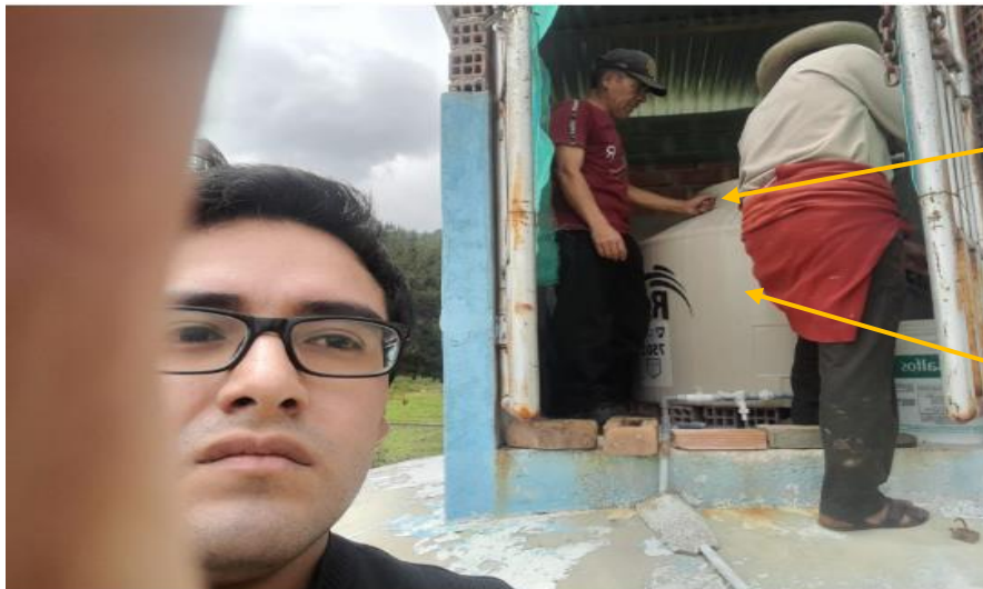
Fotografía 9 Vista de la caseta de cloración en el reservorio N°03
