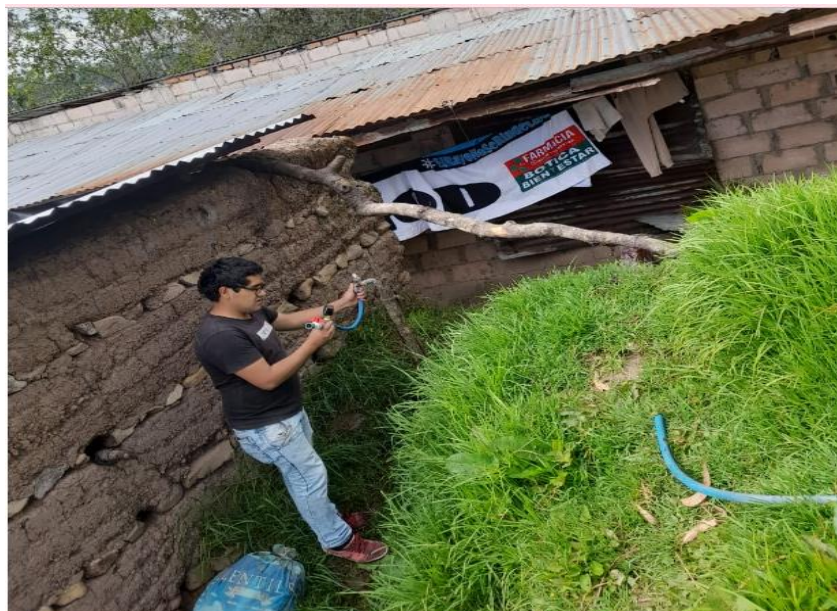
Fotografía 27 Toma de presión dinámica mediante el uso de manómetro
