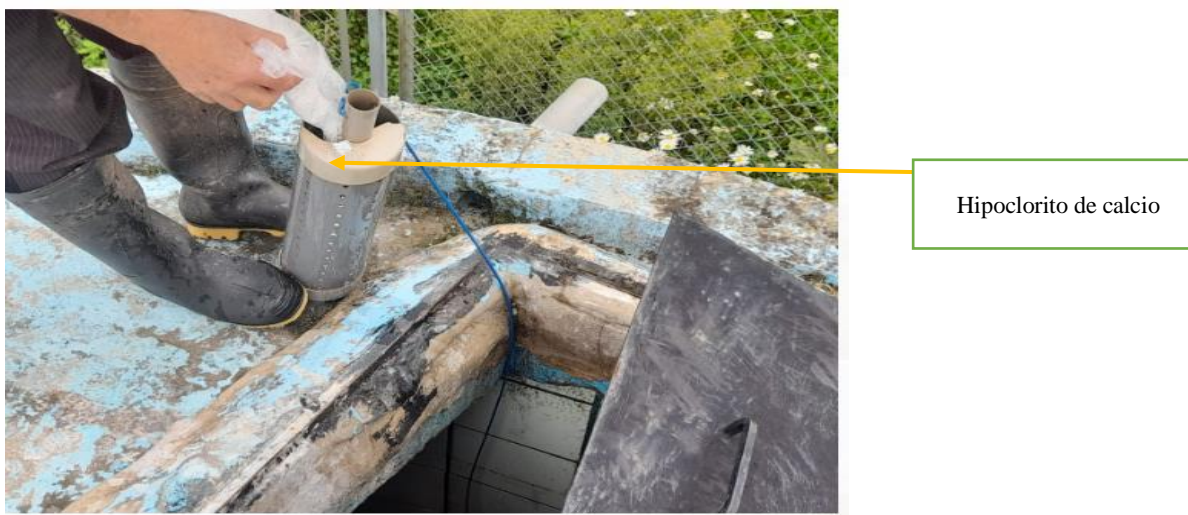
Fotografía 7 Cloración con hipoclorito de calcio en el reservorio N°02
