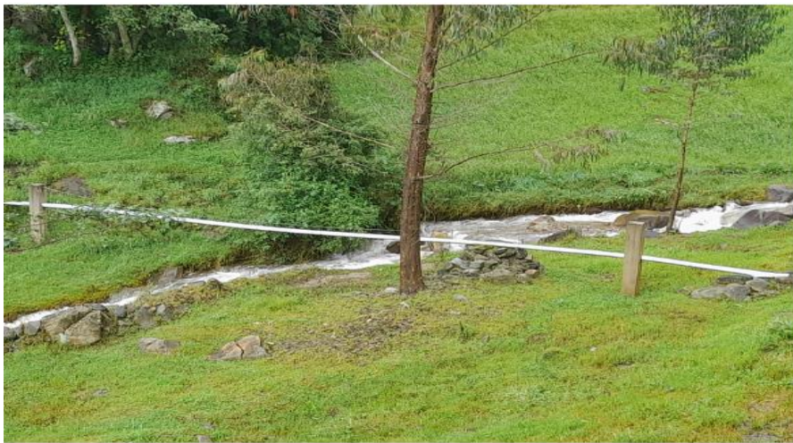
Fotografía 15 Trayecto de la línea de conducción
