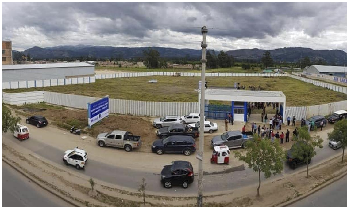
Figura N° 03. Vista panorámica de la Ubicación de la Construcción del Hospital EsSalud
