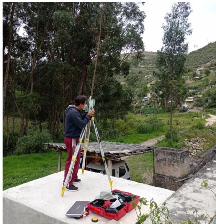
Figura 76. Levantamiento topográfico de la estructura.
