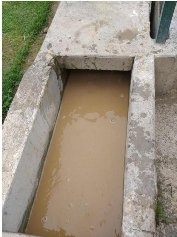
Figura 84. Agua turbia en época de lluvia observada en el canal de entrada
