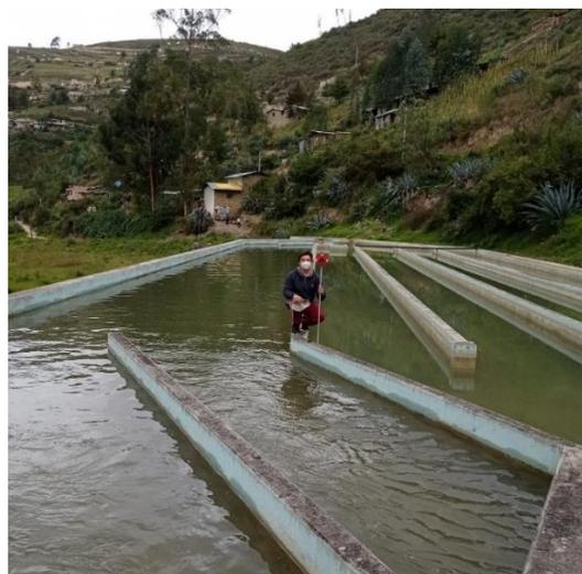
Figura 47. Proceso del levantamiento topográfico del desarenador.
