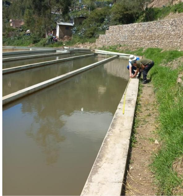
Figura 81. Medición de la distancia para medir la velocidad mediante el método del flotador
