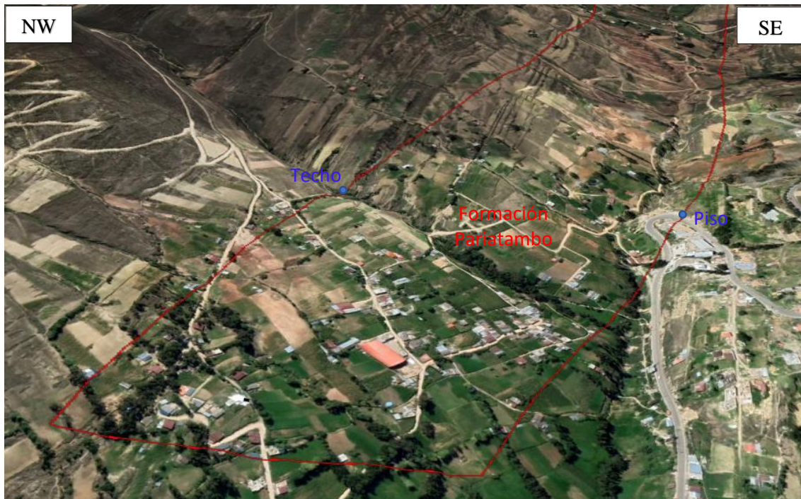
Figura 4.8. Vista panorámica desde Google Earth, delimitando la Formación Pariatambo: Piso y techo, cortado transversalmente por la Quebrada: Puyllucana y Samana, y carretera provincial - Zona Puyllucana.
