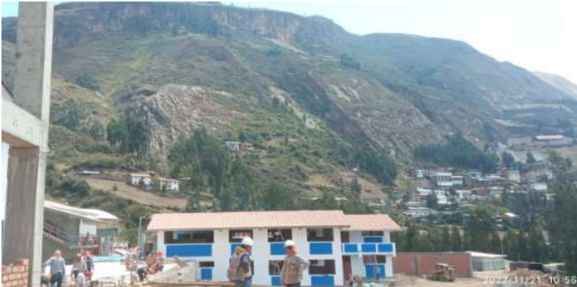
FIGURA N°30: Vista de Socavones en la montaña cercana a la institución educativa.
