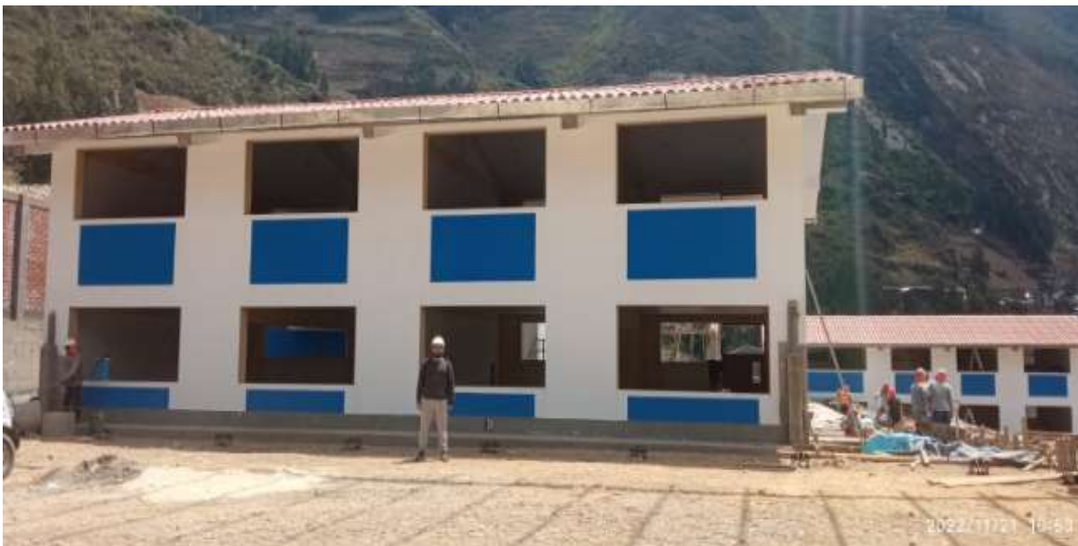
FIGURA N°27: Vista del módulo A en la fase de acabados.
