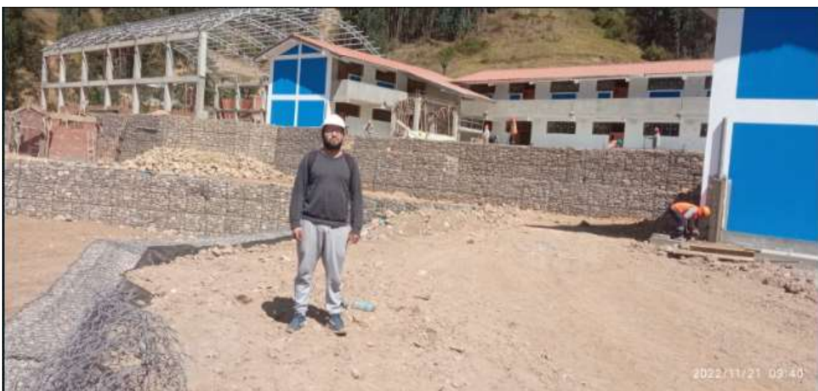
FIGURA N°29: Vista de protección con gaviones.
