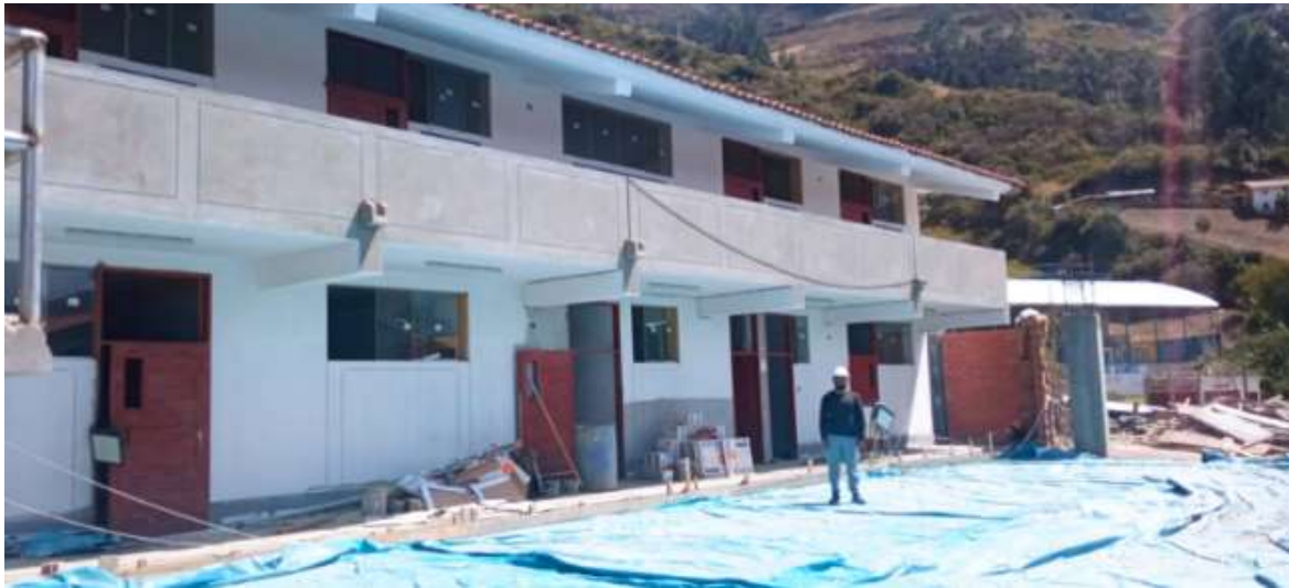
FIGURA N°26: Vista del módulo A en la fase de acabados.
