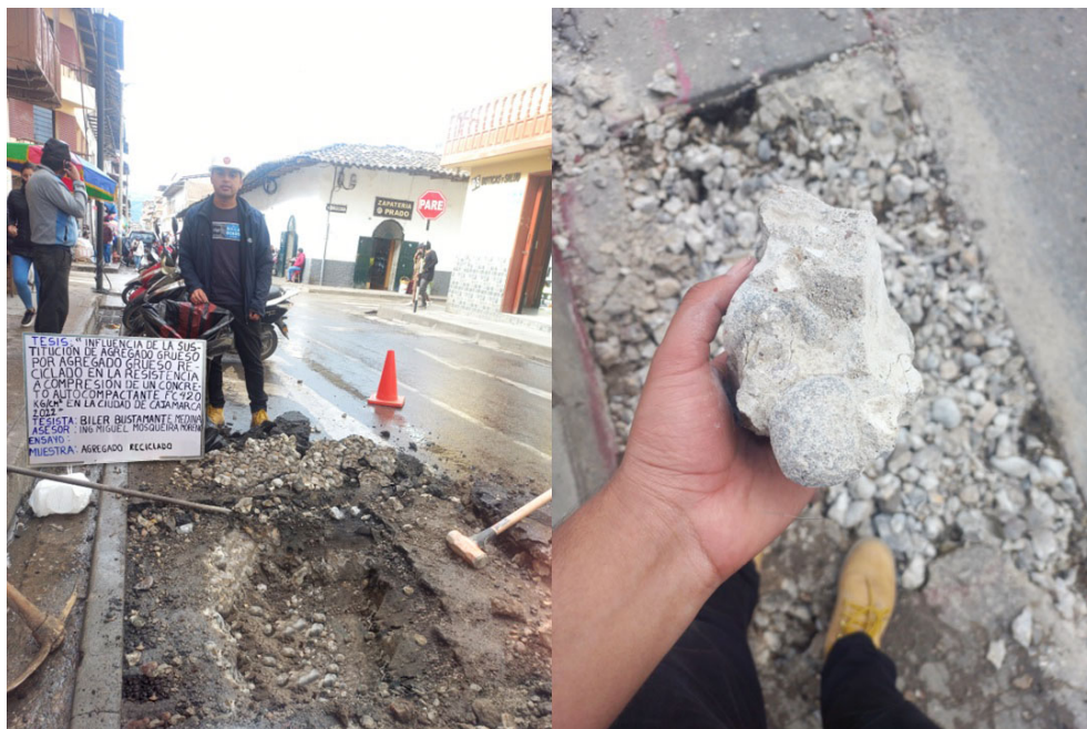
Figura N° 28: Obtención de fragmentos de concreto reciclado
