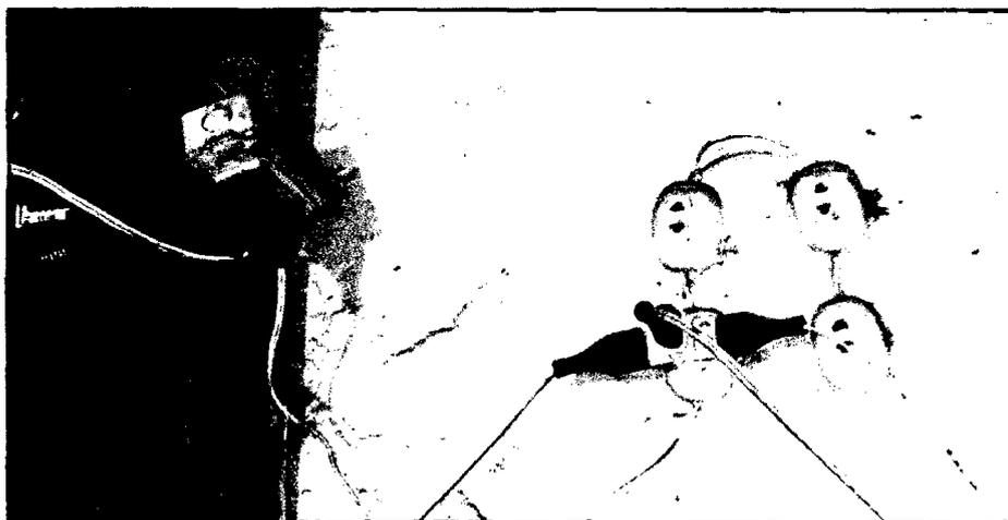
Figura 17 Mala utilización en las viviendas de conductor no normalizado de PVC y sin protección de tubería o canaleta.
