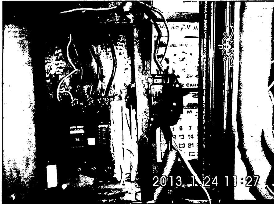
**FIGURA 34:** Tablero eléctrico de material combustible, sin mandil, con interruptor termomagnético sobredimensionado, sin interruptor diferencial. Viv. 17-Lote E
