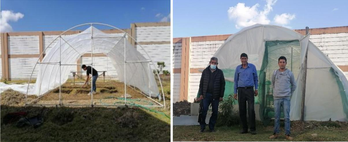
**Foto 3.** Construcción del invernadero tipo macro-túnel con tubo de luz de una pulgada y colocado del plástico agrofil calibre 8 al invernadero.
