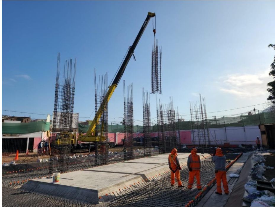
Figura 91. Izaje de columnas
