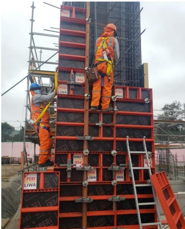
Figura 92. Encofrado de placas
