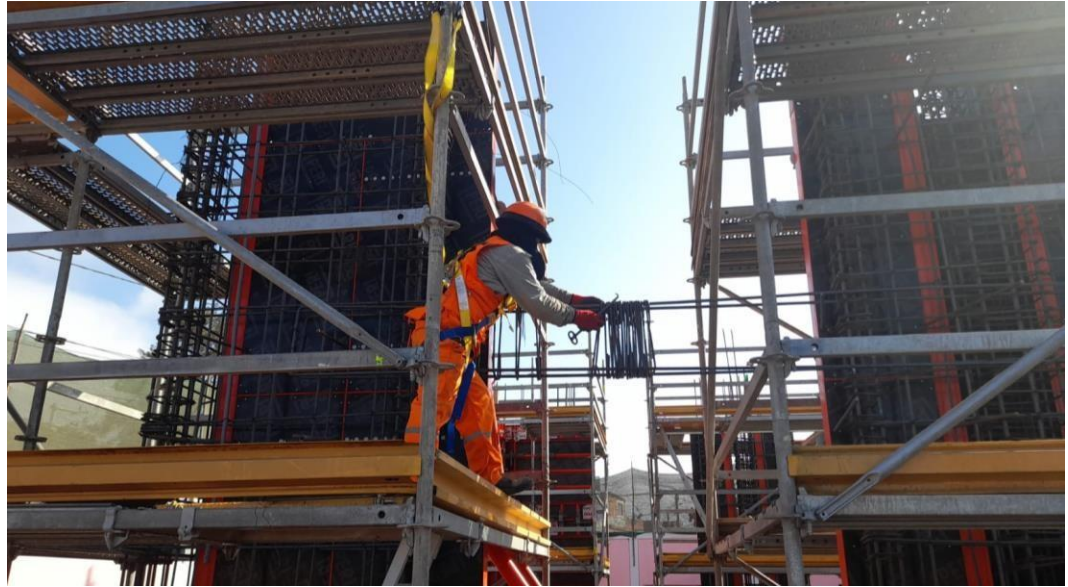
Figura 93. Colocación de estribos en vigas
