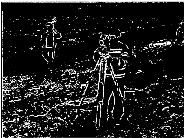
Ubicación de la primera estación y programación del equipo
