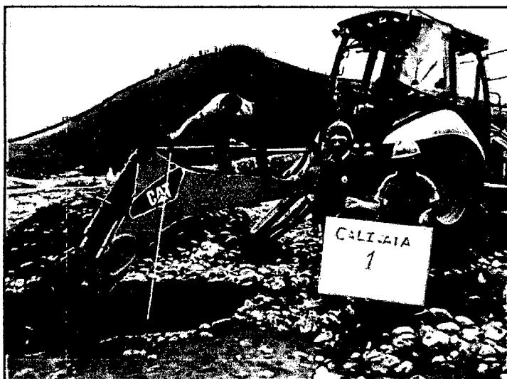
Verificación de la profundidad de excavación en la calicata N° 1
