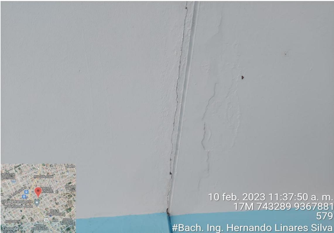
Foto 5: Presencia de fisura en losa aligerada.
