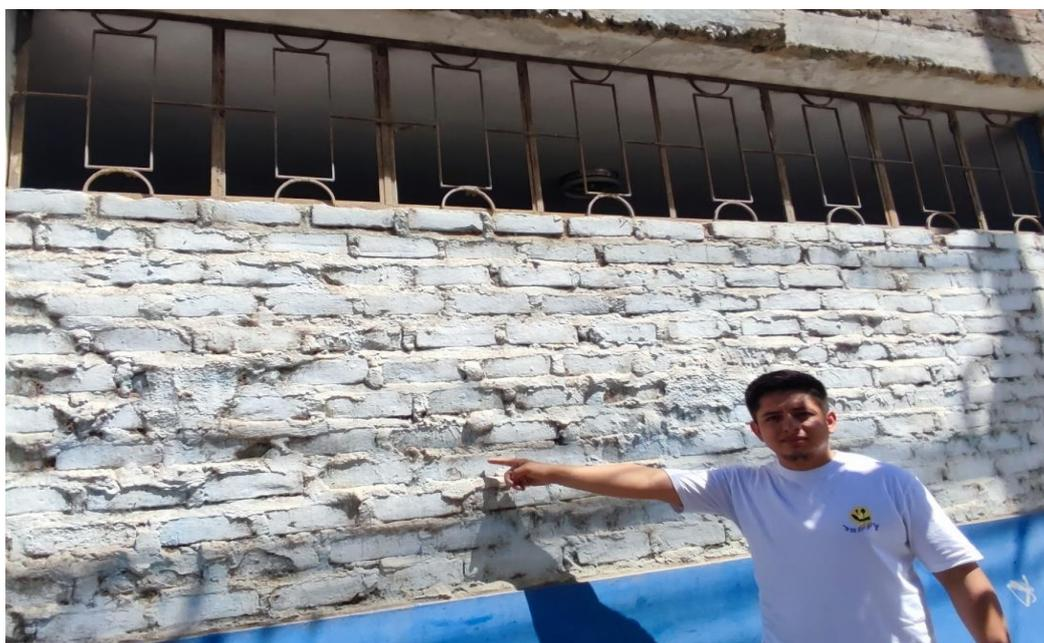
Se asignó una calificación de clase C (malo) a este parámetro debido a que está construido con mampostería de ladrillo de calidad regular, con piezas no uniformes y dimensiones variables en toda la extensión del muro, como se puede observar en la figura 18.
