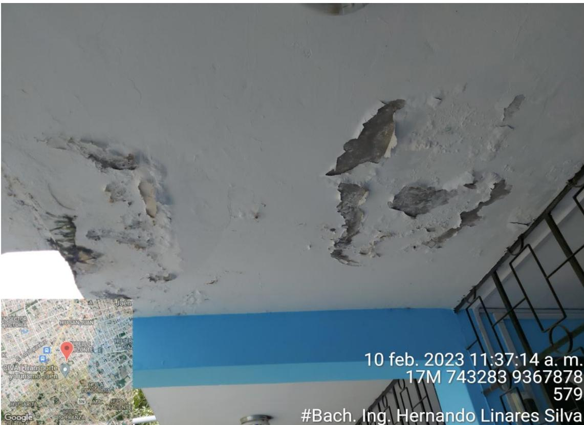
Foto 6: Presencia de humedad en losa aligerada del segundo nivel.
