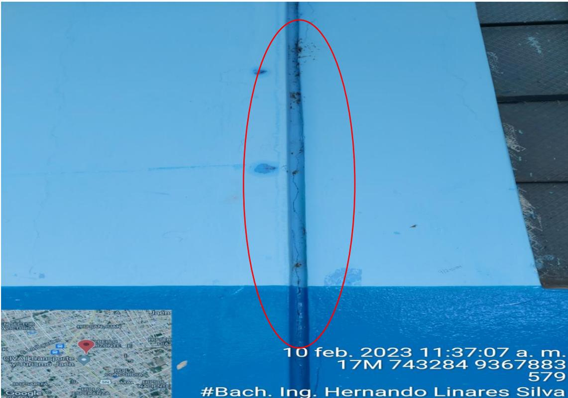
Foto 7: Presencia de fisura en junta de separación entre el Pabellón A y los SS. HH.
