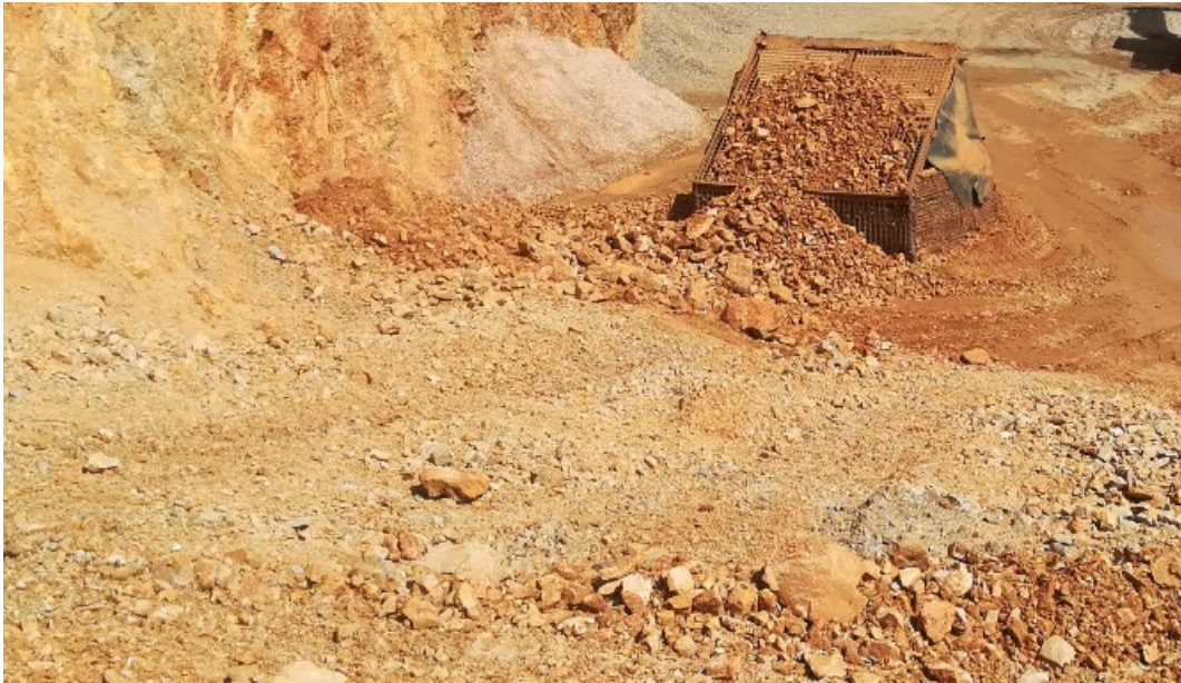
Foto 05. Zona de zarandeo de material excavado.
