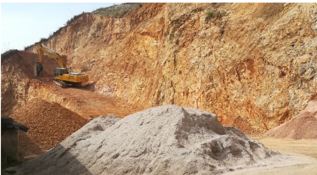
Foto 04. Proceso de excavación con martillo hidráulico.
