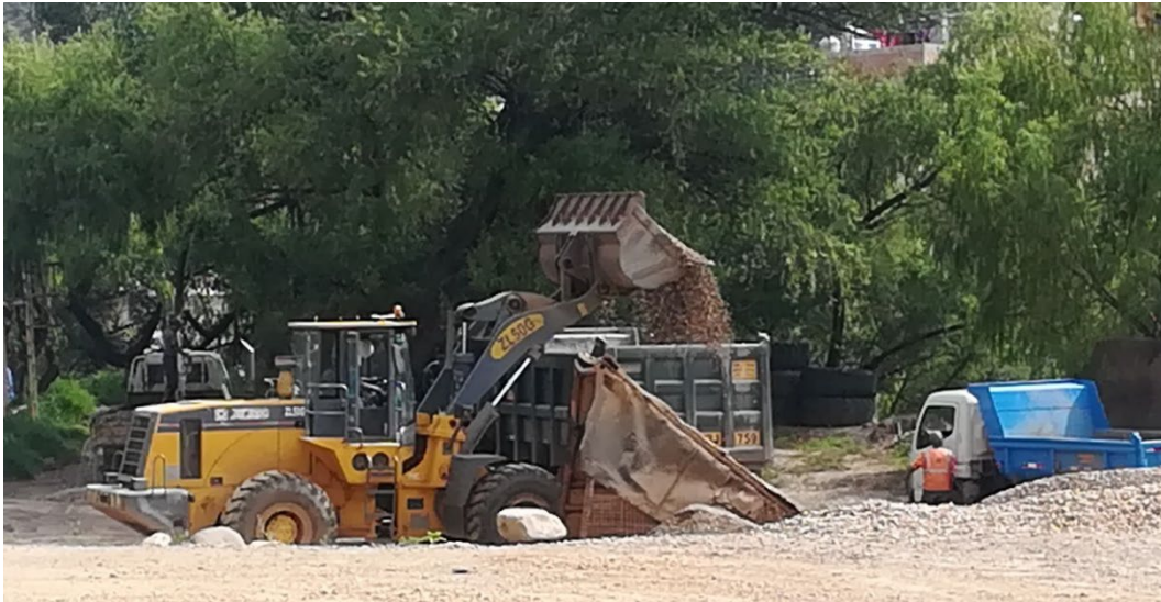
Foto 07. Zona de carguío 02 – Cantera Platero Chuco.
