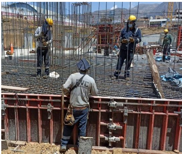
Verificación de encofrado en platea de cimentación.
