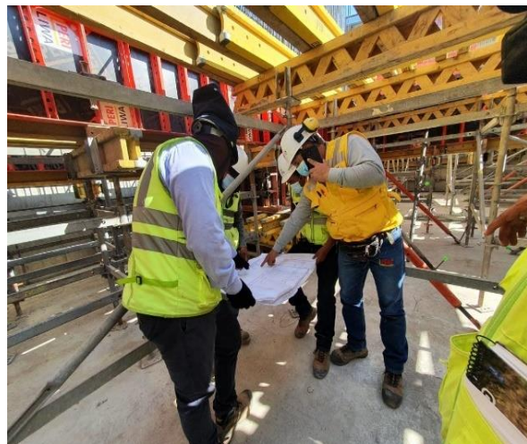
Explicación in situ de planos de modulación por la empresa Peri encofrados.
