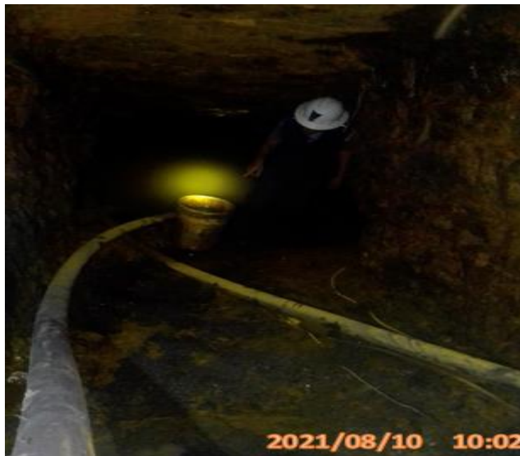
Foto 10: Aforando el agua de las labores
