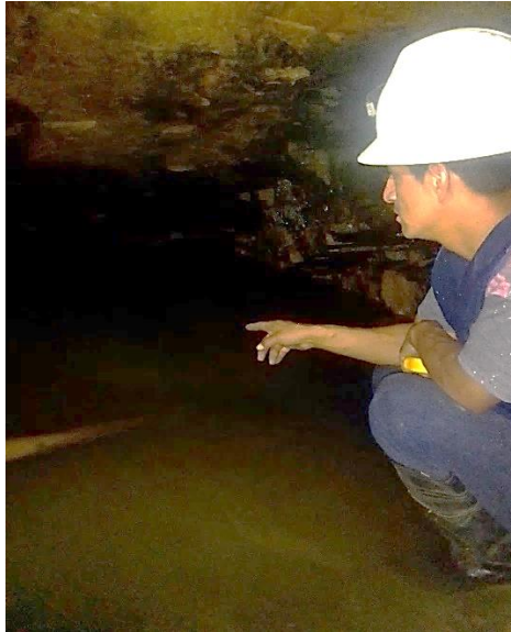
Foto 7: Reconocimiento de la poza de sedimentación
