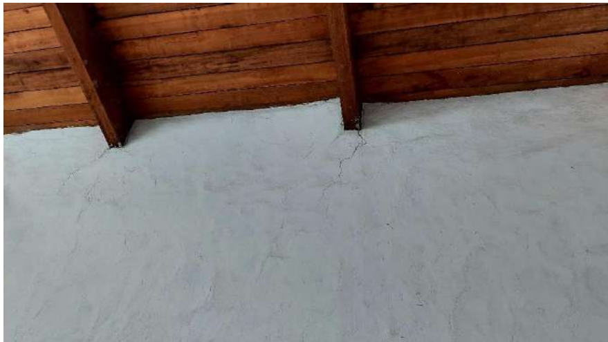
Figura 35. Grietas bajo la cubierta en los muros de la nave
