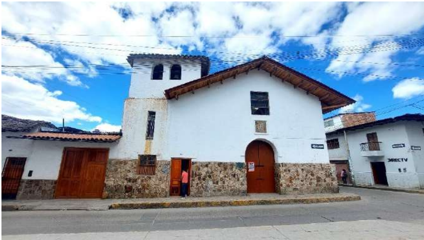
Figura 1. Midiendo la arquitectura de la iglesia San José
