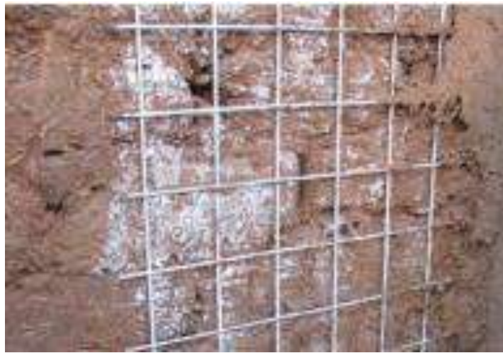
Figura 12. Malla electro soldada para refuerzo estructural
