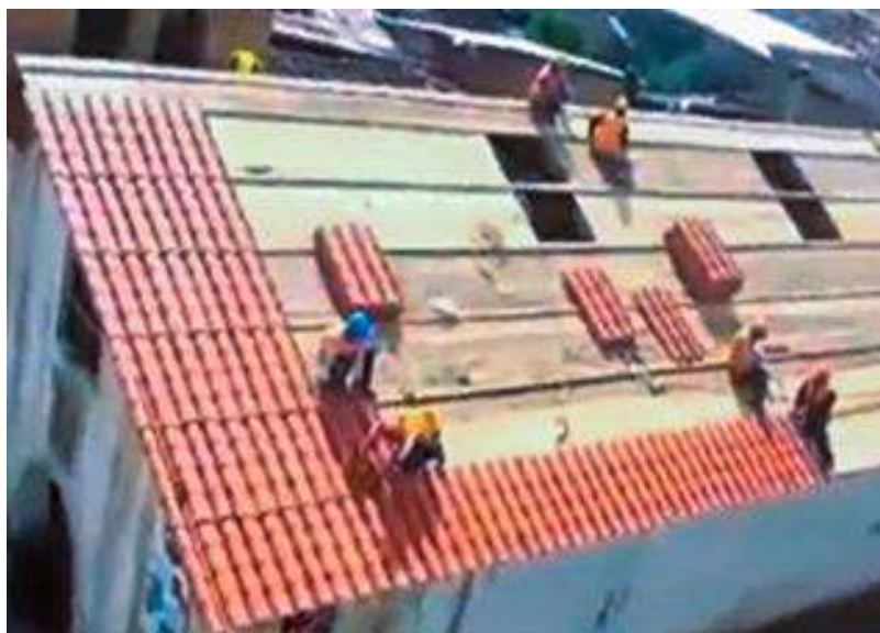
Figura 20. Instalación de teja andina en la iglesia San José
