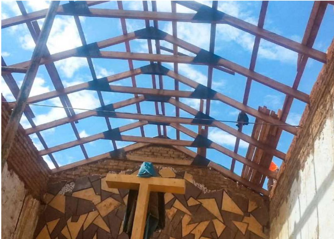
Figura 18. Trabajos de intervención en techo en la iglesia San José, 2015
