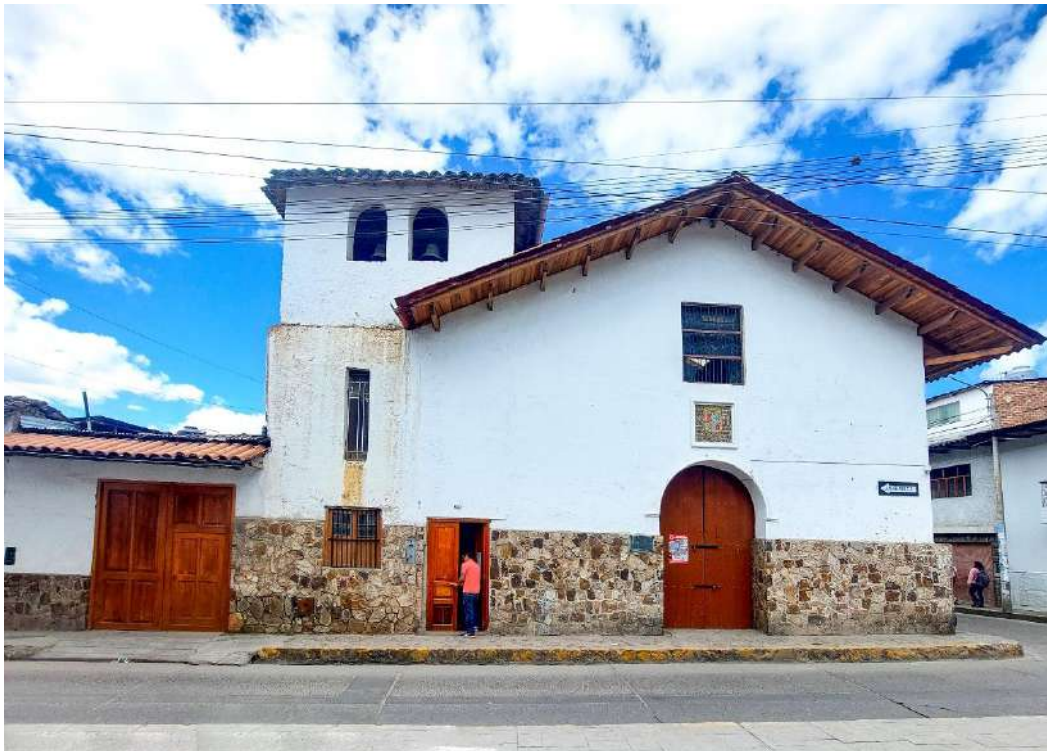
Figura 16. Vista actual de la iglesia San José desde Jr. Miguel Iglesias
