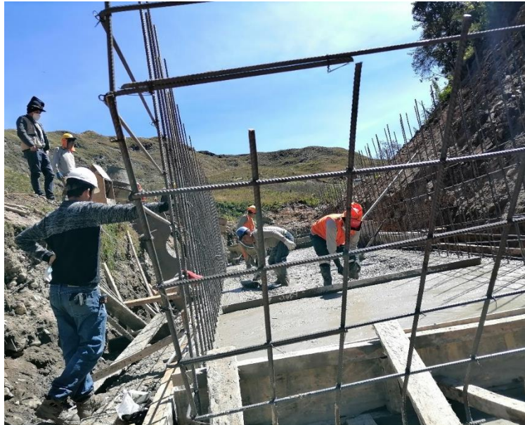
FOTO N° 01.- Vaciado de concreto 210kg/cm2 en losa del sedimentador de agua
