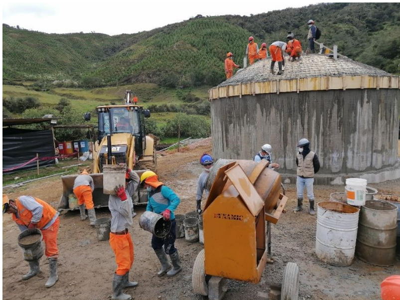
FOTO N° 02.- Vaciado de concreto 210kg/cm2 en la cúpula del reservorio
