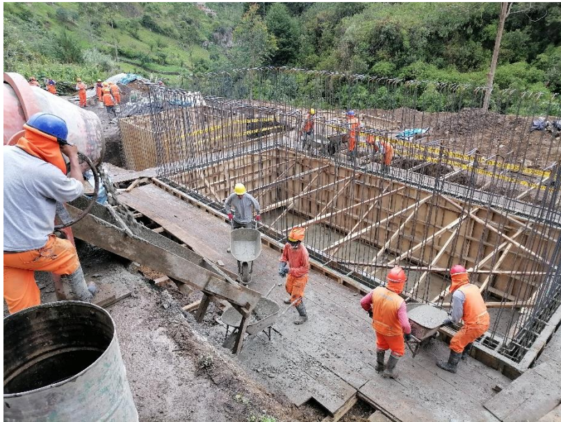
FOTO N° 03.- Vaciado de concreto 210kg/cm2 en el muro del tanque imhoff
