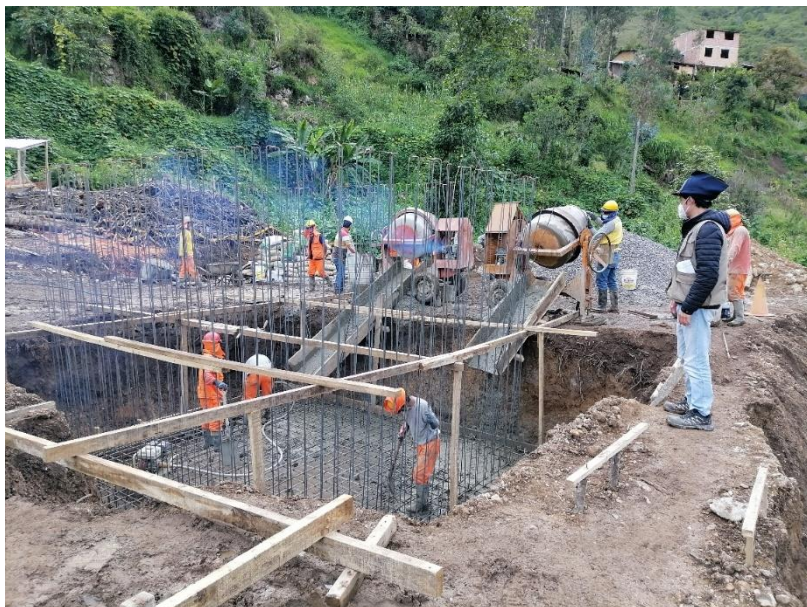
FOTO N° 04.- Vaciado de concreto 210kg/cm2 en la losa del filtro biológico
