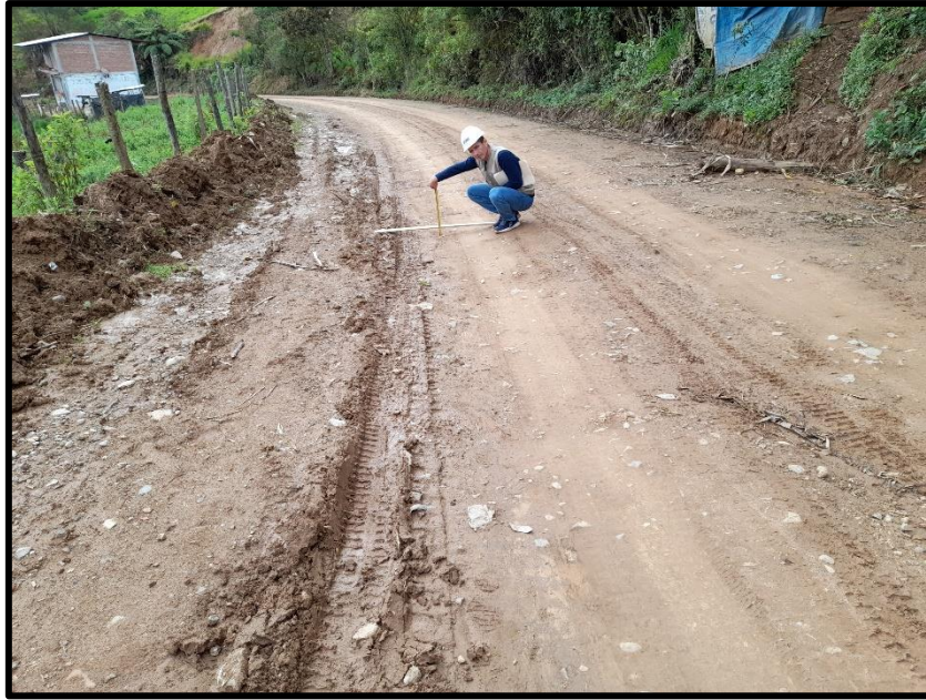
Figura 28. Deformacion (km 2+000 – 2+500)
