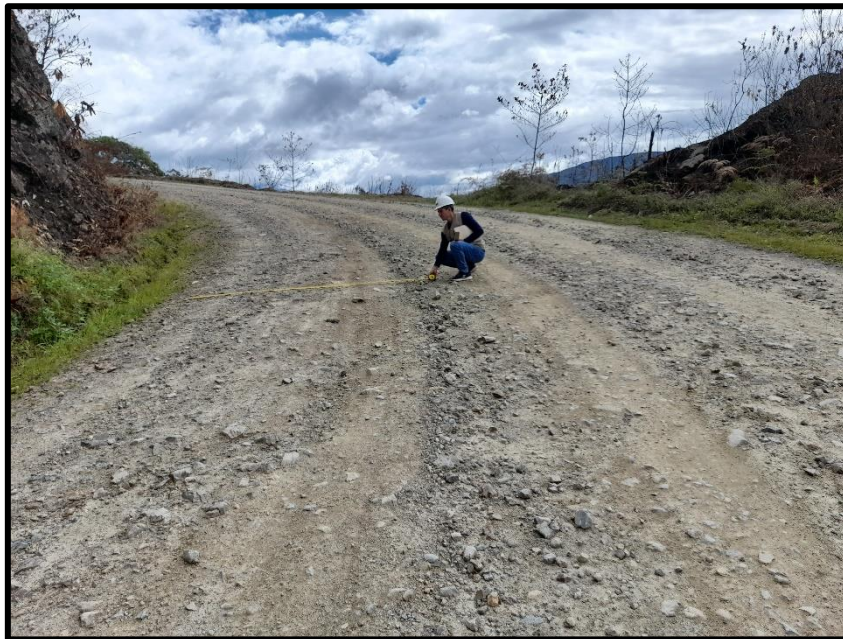
Figura 23. Deformcion (km 0+500 – 1+000)
