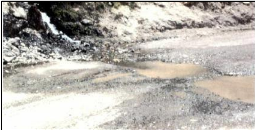
Figura 12. Cruce de agua
