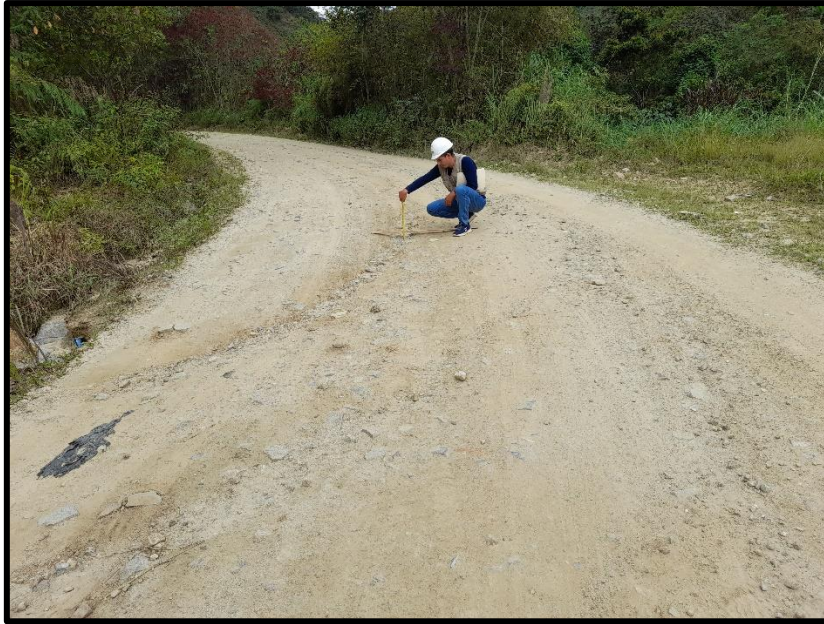
Figura 22. Erosión (km 0+500 – 1+000)
