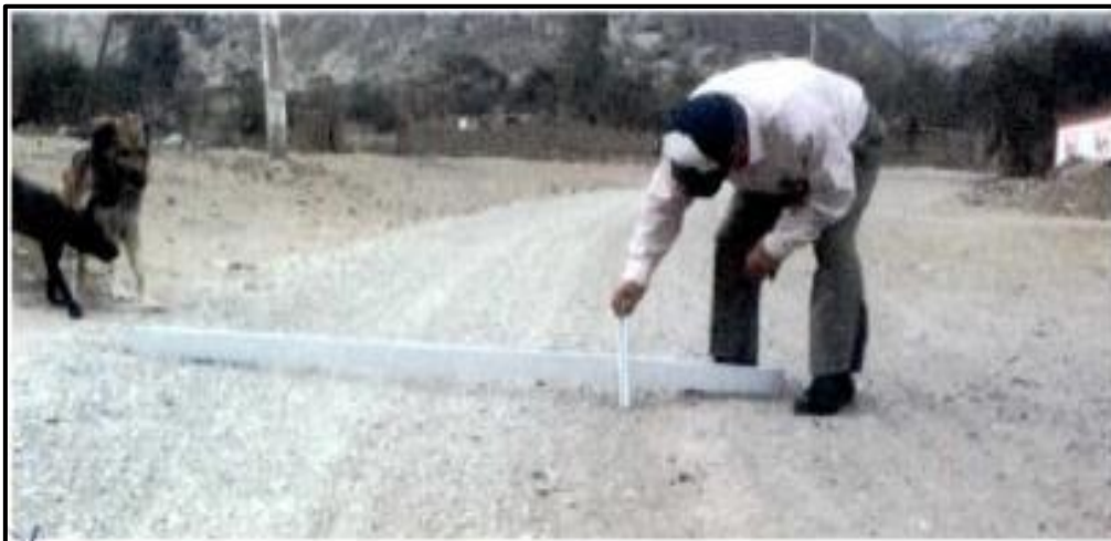
Figura 2. Gravedad 2: Huellas/hundimientos entre 5 cm y 10 cm
