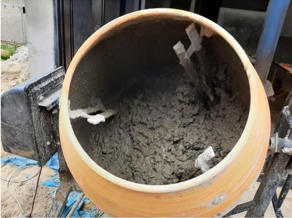
*Fotografía 7. Mezclando materiales en el trompo.*
