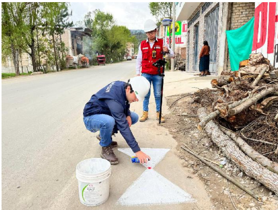
Fotografía 4. Fotografía 5: Marcado de puntos de control y apoyo a lo largo del tramo Chota – El Paraíso
