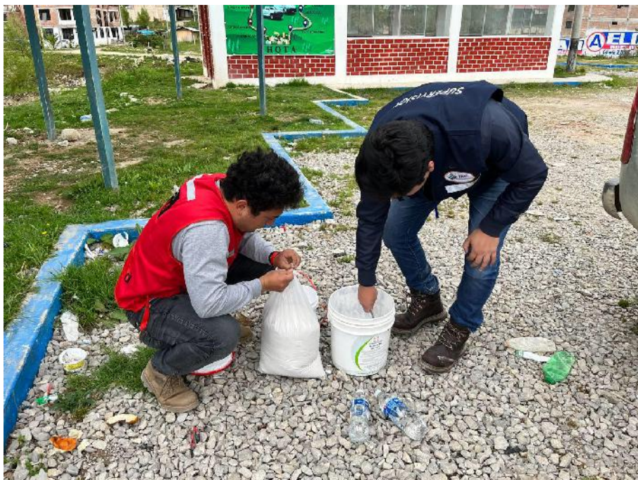
Fotografía 2. Preparación de pintura para el marcado de puntos de control y apoyo a lo largo del tramo Chota – El Paraíso
