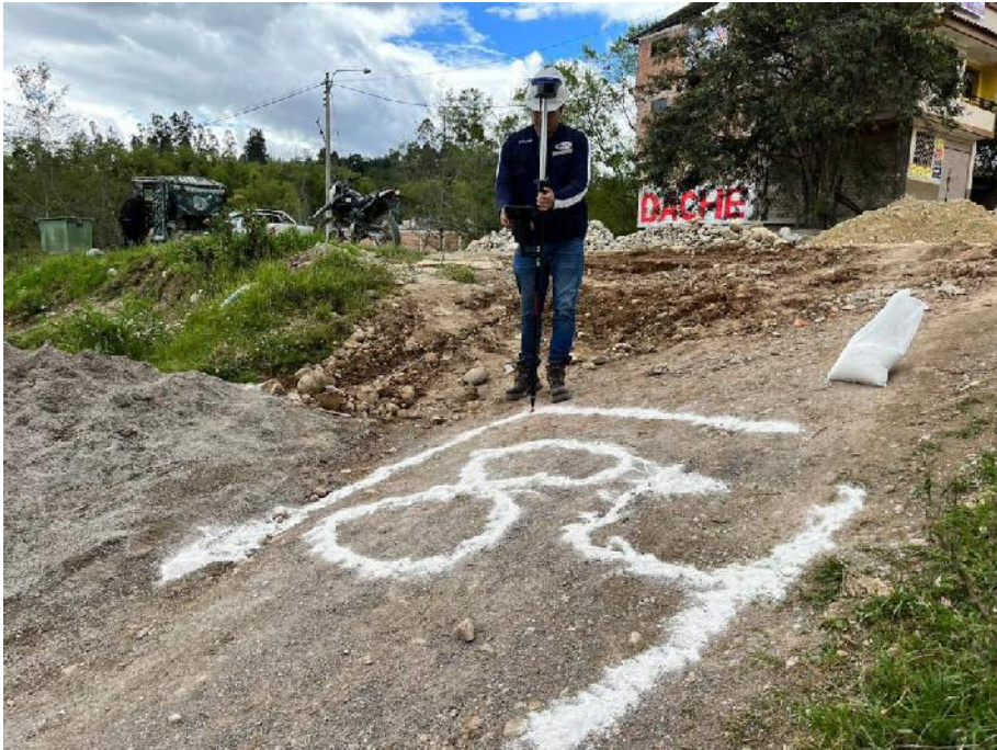
Fotografía 6. Toma de punto de apoyo 84 con el rover
