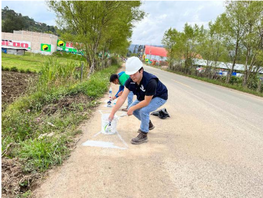
Fotografía 3. Marcado de puntos de control y apoyo a lo largo del tramo Chota – El Paraíso
