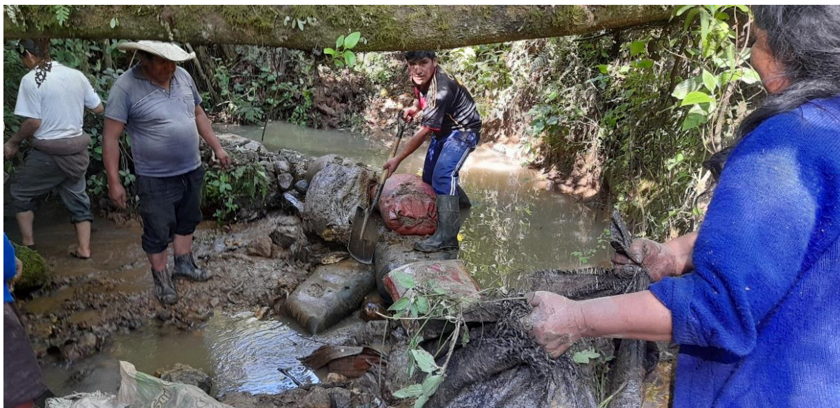
Figura 58. Participando de la construcción de una bocatoma, para el canal denominado Horno Pata, en el anexo Capilla, con el fin de disminuir la filtración, utilizamos sacos de nailon y arena. (junio 2022).
