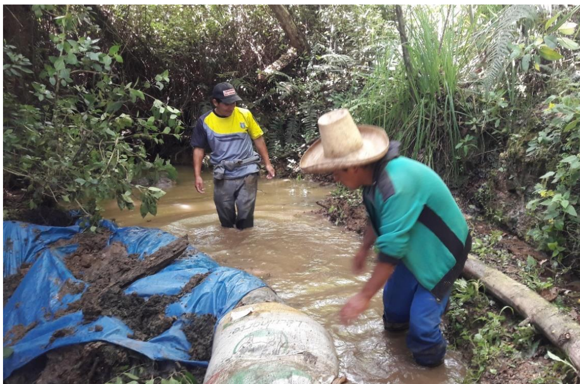
Figura 57. Participando de la construcción de la bocatoma perteneciente al canal de regadío Horno Pata, los materiales utilizados son barro, plástico, arena, madera, partículas de madera y sacos de arroz o de abonos – anexo Capilla. (mayo 2021).
